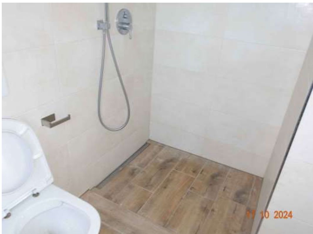
Abbildung 16: Wand-WC mit bodengleicher Dusche im Dachgeschoss
