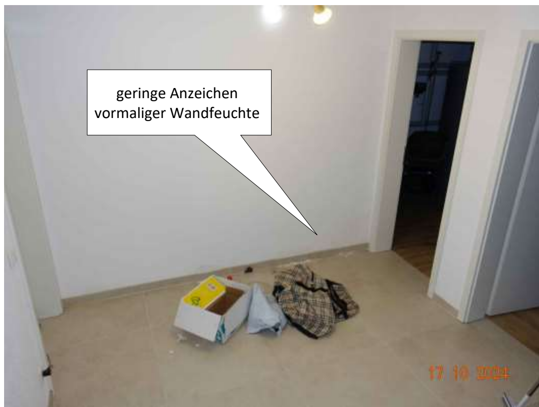
Abbildung 17: Flur im Keller
