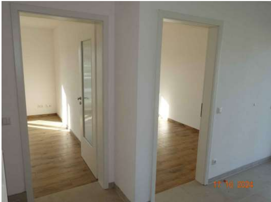
Abbildung 11: Türen im Obergeschoss, teilweise mit Glaseinlagen
