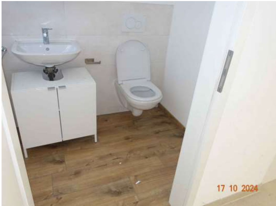
Abbildung 7: WC am Hauseingangsbereich
