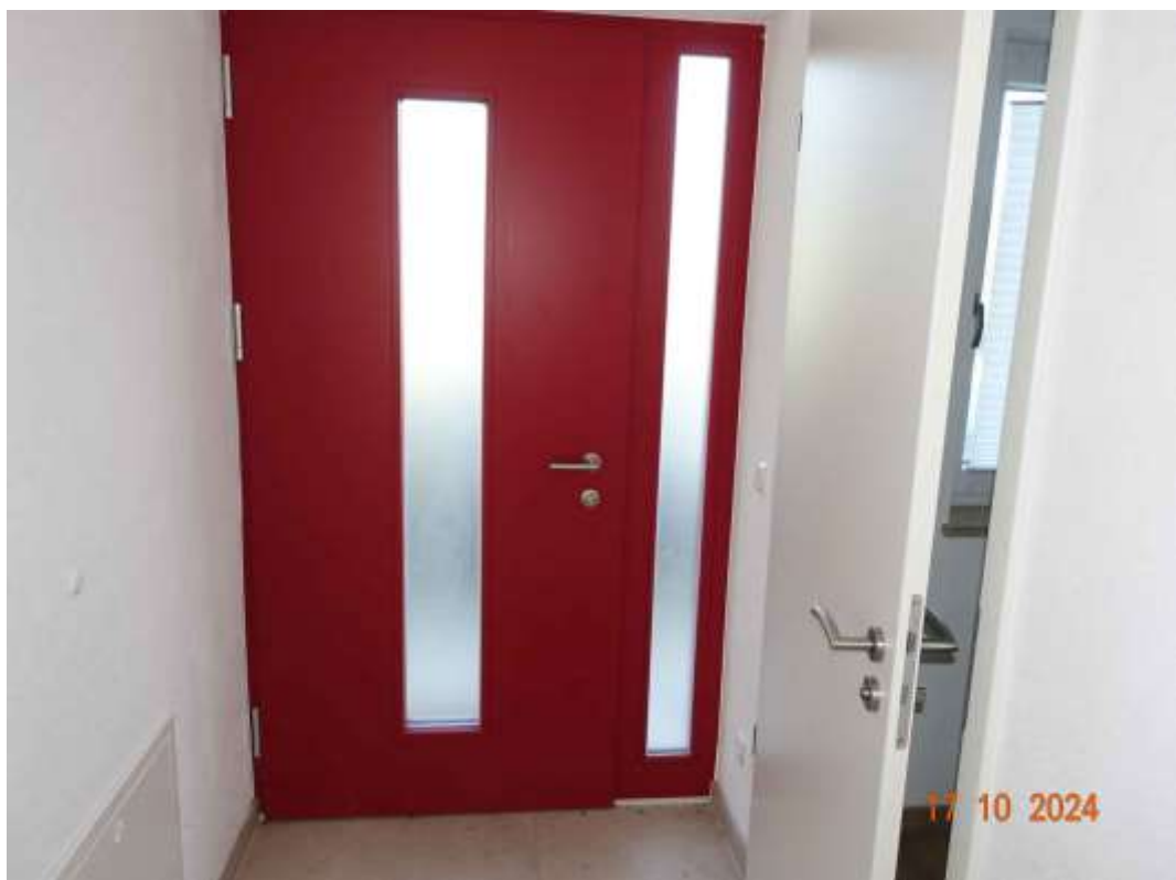
Abbildung 6: Eingangsbereich mit Hausabschlusstür und Zugang zum WC
