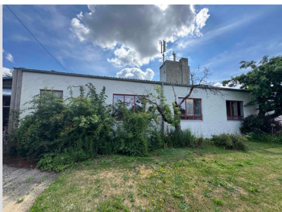
Werkstattgebäude, Ansicht von Westen
