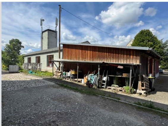
Werkstattgebäude, Ansicht von Nordosten
