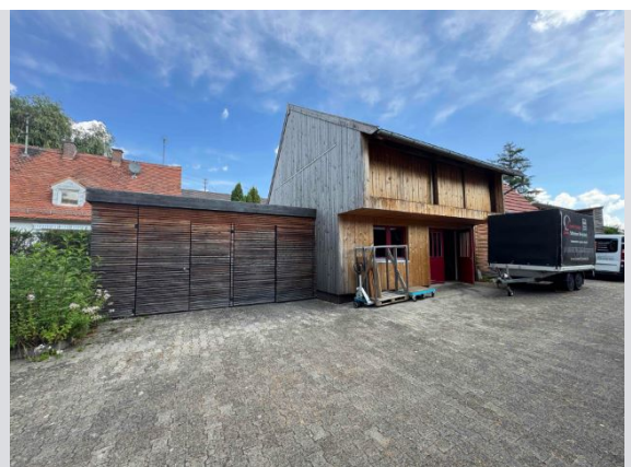
Garagen-/Lagergebäude West, Ansicht von Südwesten
