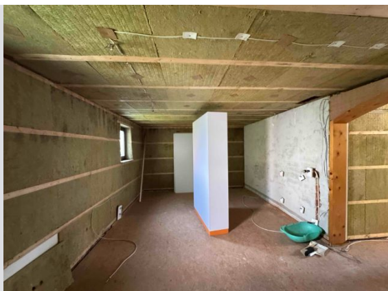
Lagergebäude West, EG
