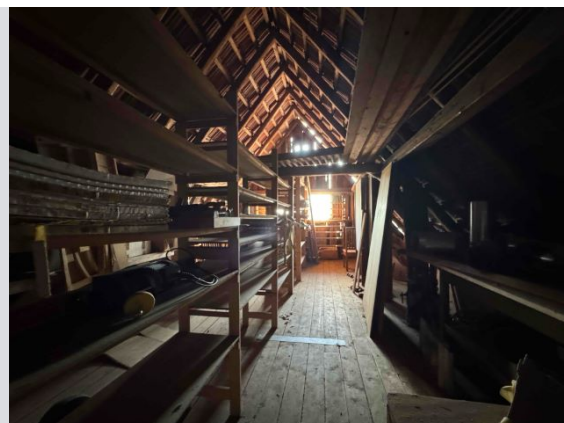
Lagergebäude Ost, DG
