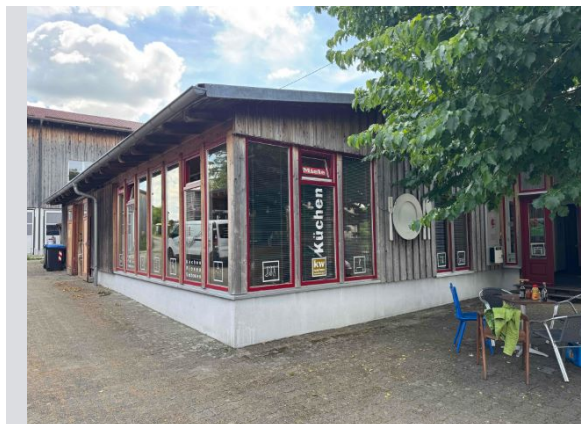
Werkstattgebäude, Teilansicht von Nordwesten
