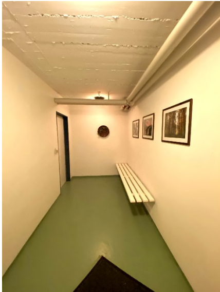
Bild 24 – Schwimmhalle, Blick nach Norden
