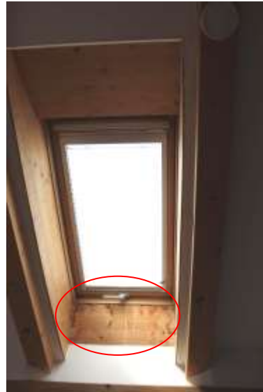
Abb. 29c: Dachflächenfenster Wasserpuren
