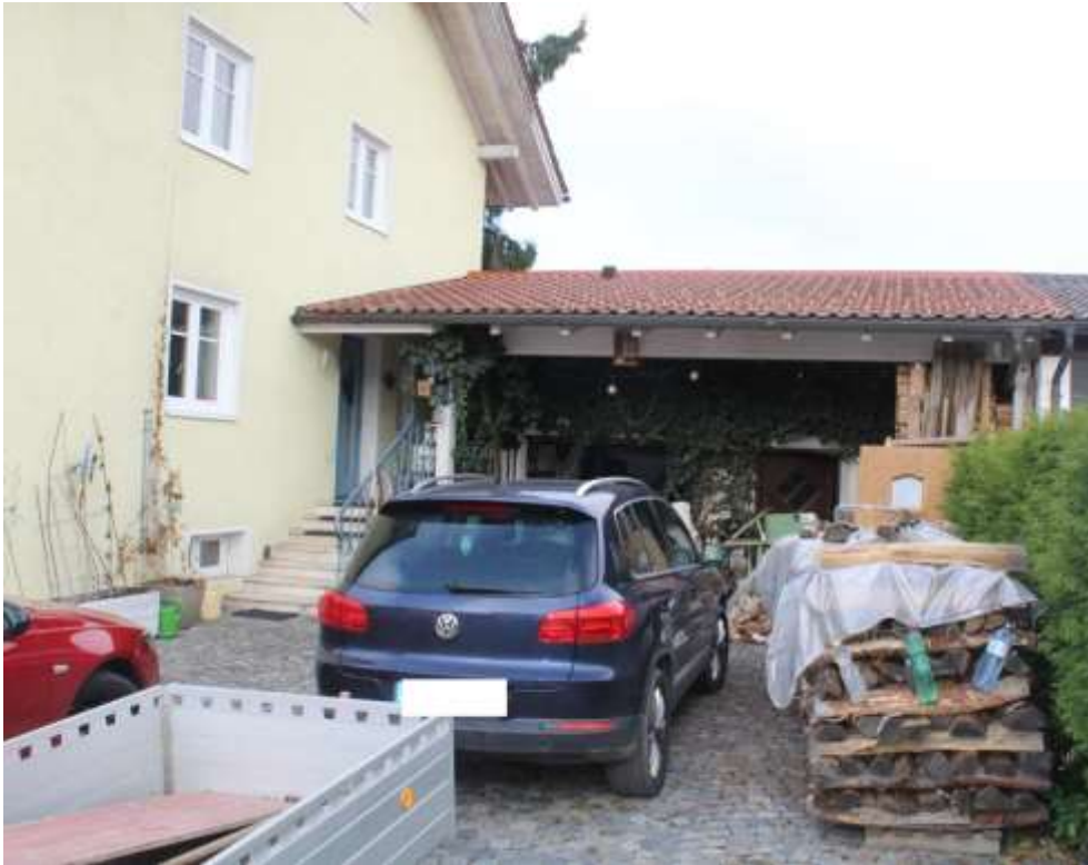
Abb. 2: Südansicht Garage mit Nebenraum
