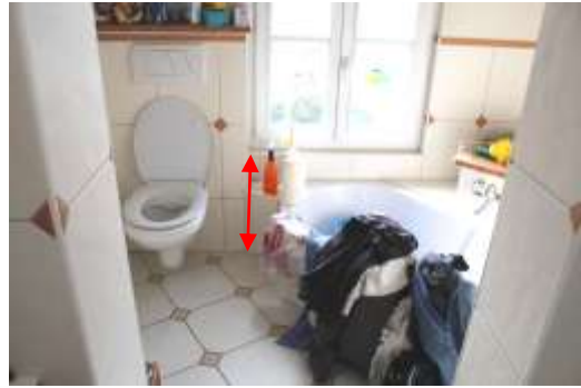
Abb. 26a: Badewanne niedrige Brüstung zum Fenster
