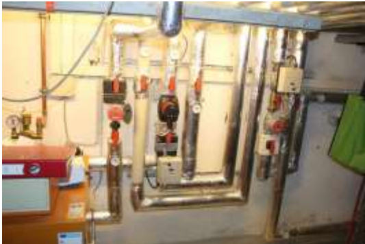
Abb. 35a: Rohrisolierung
