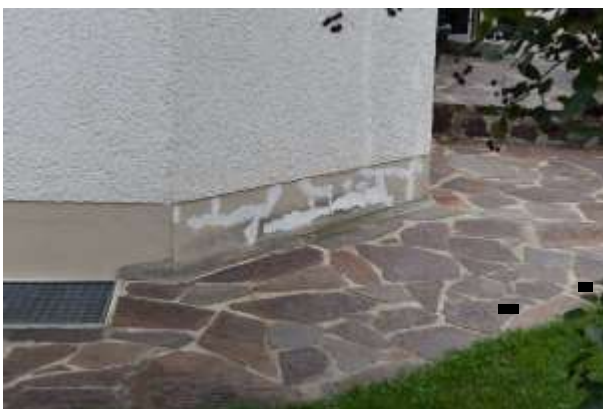
Schadhafte Stellen beim Sockelputz
