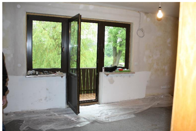
Die Heizkörper sind entfernt, die Nischen zugemauert und verputzt (helle Flächen).
