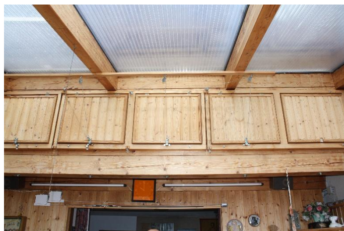
die Lüftungsklappen, wie in der Baubeschreibung ausgeführt
