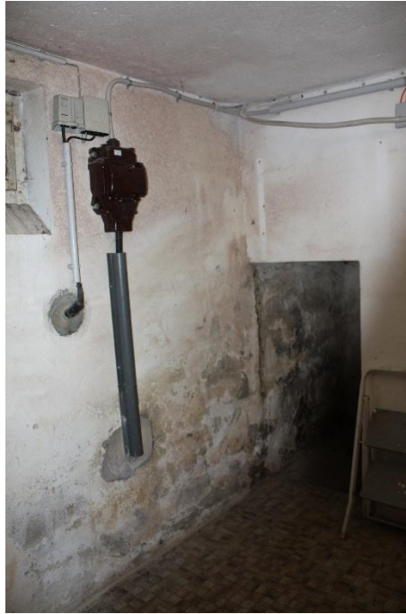
Feuchtigkeitsschäden an den Kellerinnenwänden
