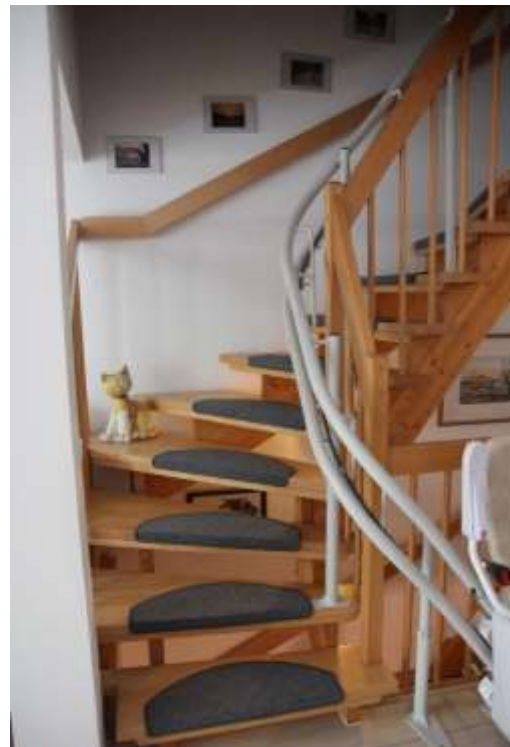
Treppe ins Dachgeschoss mit Treppenlift
