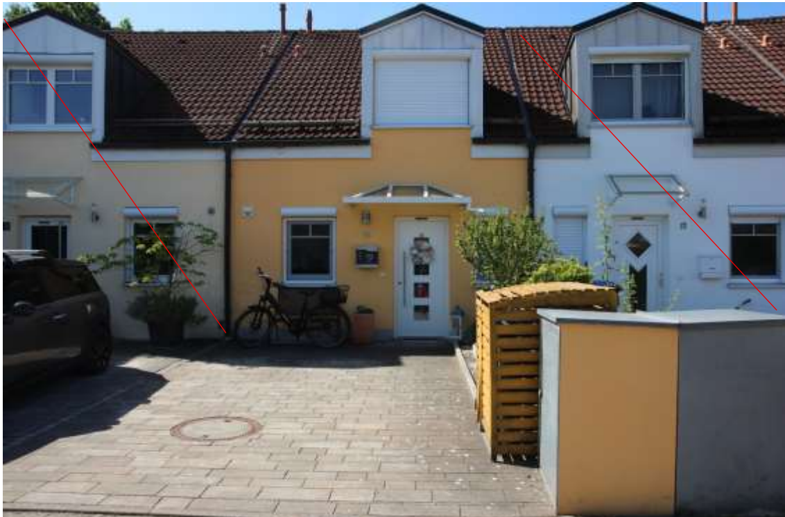
Nordansicht Reihenhaus mit PKW-Außenstellplatz
