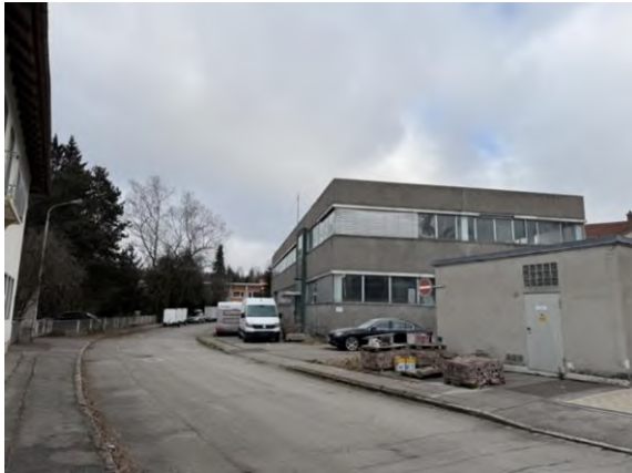
Ansicht Betriebsgebäude mit Trafostation
