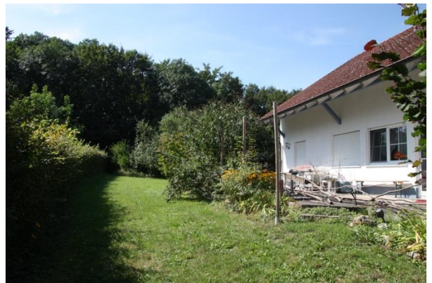
Ansicht von Osten, Gartenbereich
