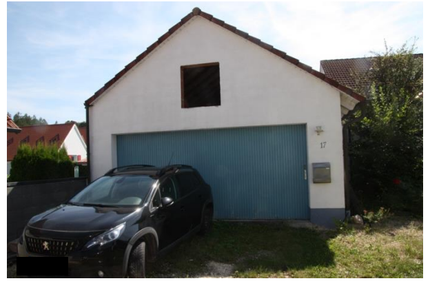
Ansicht Doppelgarage von Norden
