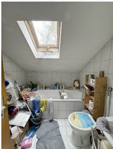
Bild 19 und Bild 20 – Bad DG
