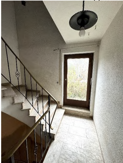
Bild 34 und Bild 35 – Treppenhaus OG
