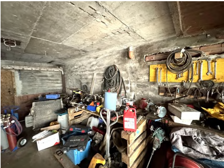
Bild 61 – Abplatzung an Betondecke und Feuchtigkeitsschäden an Wänden
