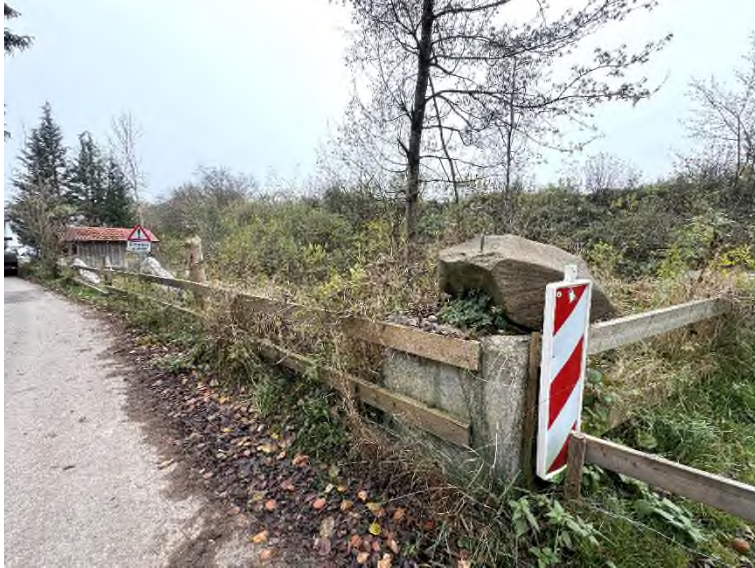
Bild 65 – westlicher Bereich, Blick nach Osten
