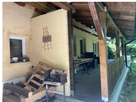
Überdachte Loggia, Gebäudenordseite
