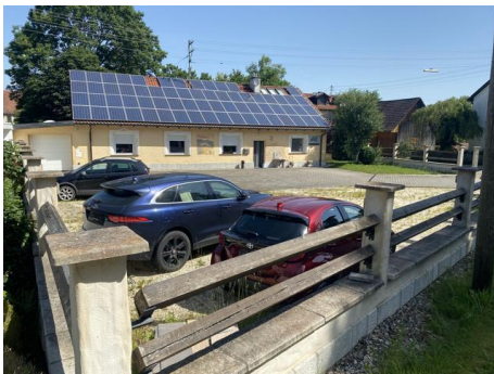
Ansicht von Süden mit Blick auf Innenhof
