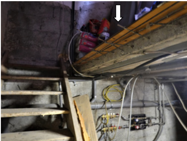
Dünne Estrichschicht auf Lehm Boden im KG
