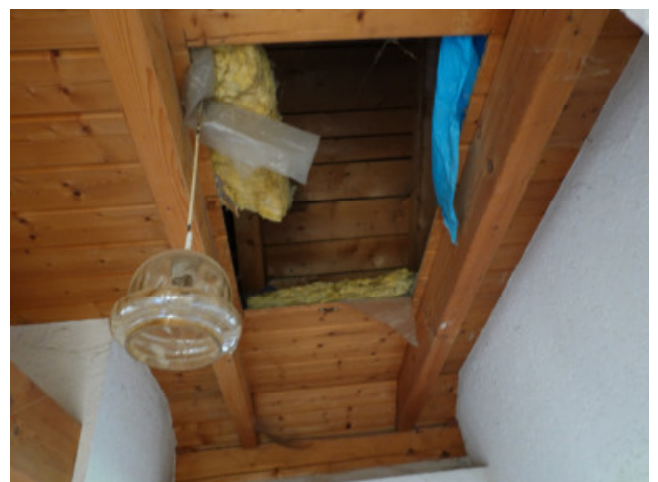
Decke zum Dachspitz mit loser Dämmung
