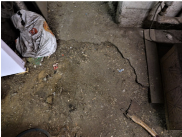
Dünne Estrichschicht auf Lehm Boden im KG
