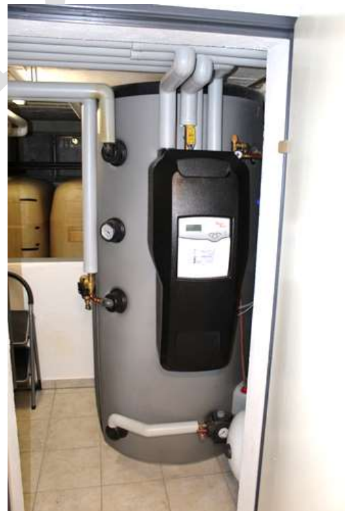
Abb. 30: Heiz-/Tankraum - Warmwasserspeicher
