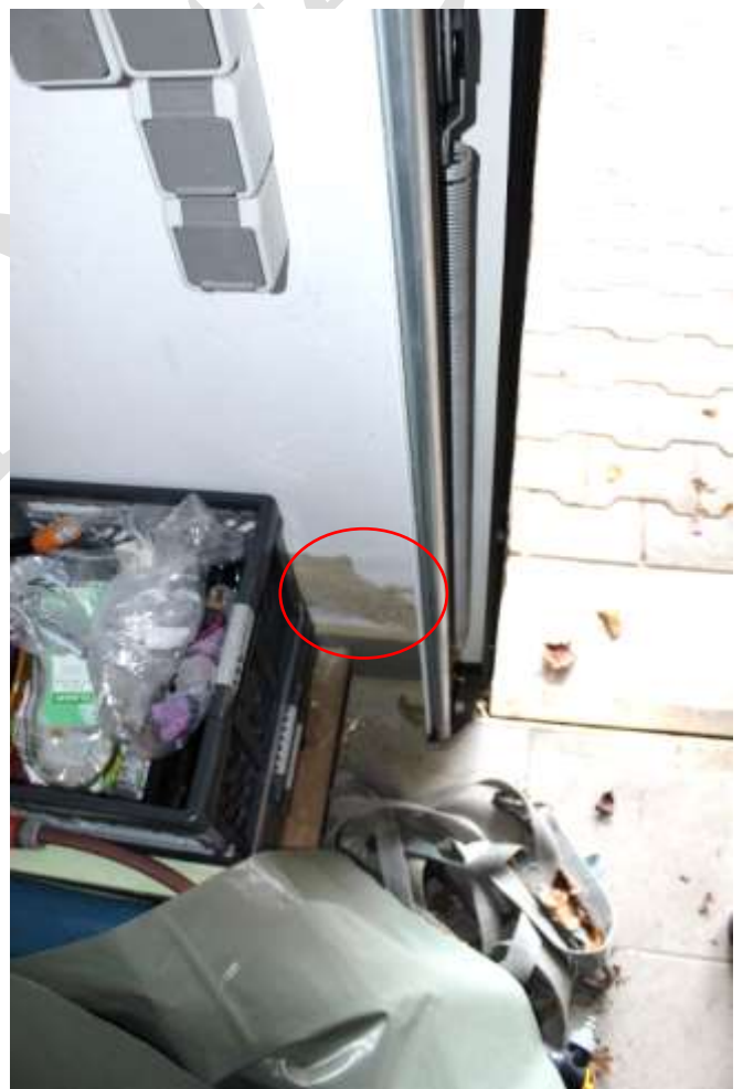
Abb. 34: Putz-/Farbschäden Sockelbereich Garage innen
