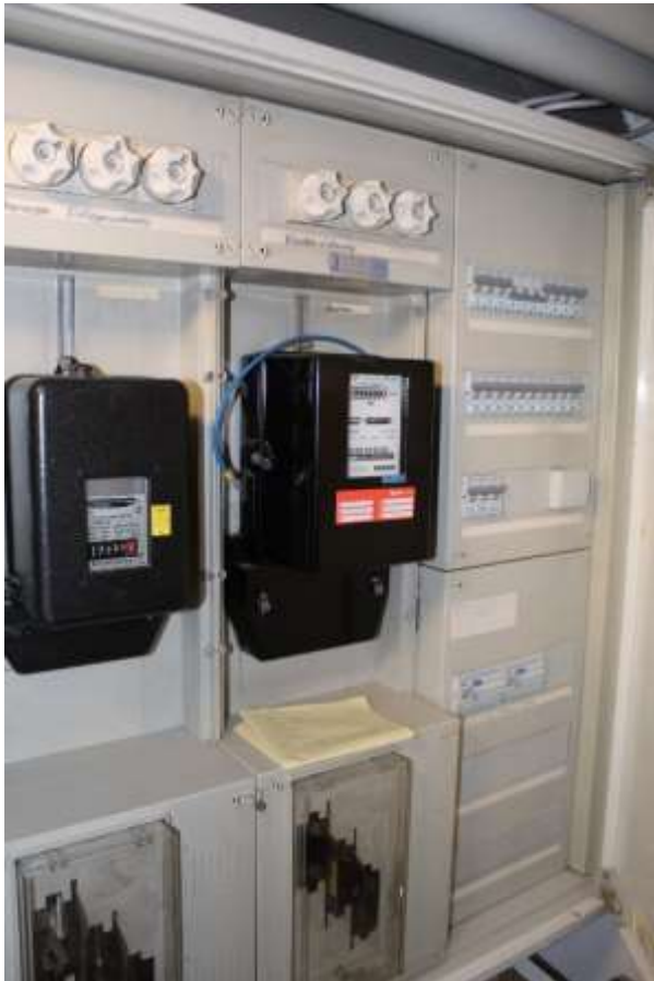
Abb. 27: Sicherungskasten, Stromzähler Keller
