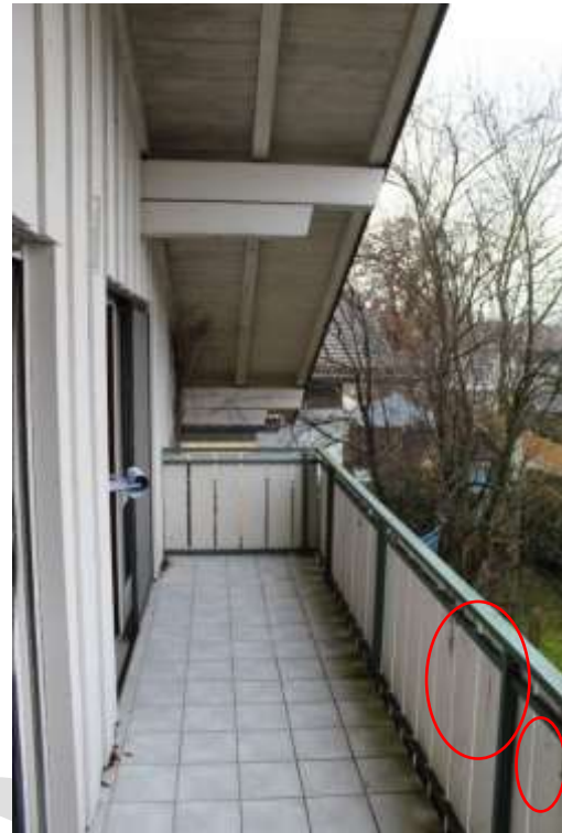
Abb. 23: Balkon – Westseite verwitterte Holzteile (beispielhaft)
