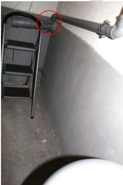
Abb. 32: Ölauffangwanne - Rohrführung durch Abdichtung u. Erdreich
