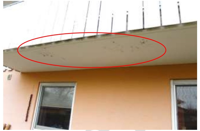
Abb. 36: Balkonuntersicht Putz-/Farbschäden
