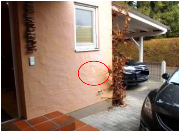
Abb. 35: Ostfassade Putz-/Farbschäden
