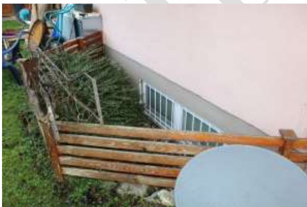
Abb. 7: Westseite - Lichtgraben Büroraum im Keller, Umwehruung (verwitterte Holzteile, < 90 cm)
