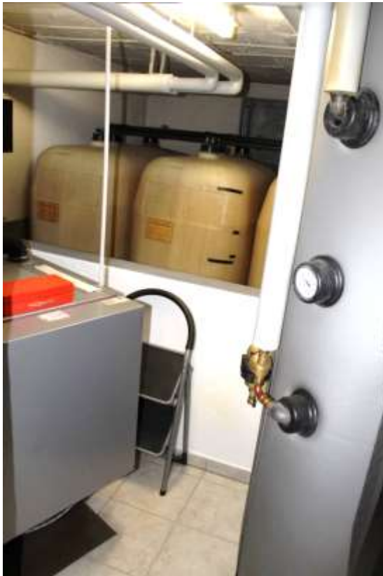
Abb. 31: Heiz-/Tankraum mit Heizung, und Kunststoff-Öltanks
