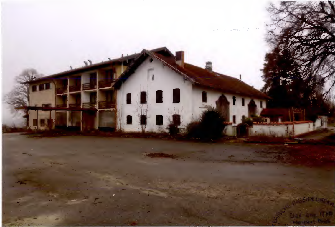
Ansicht von Norden
