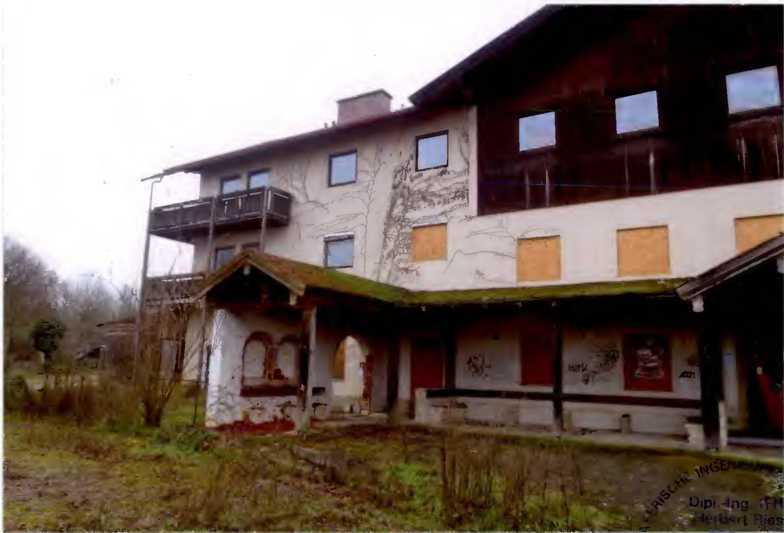
Ansicht von Südosten
