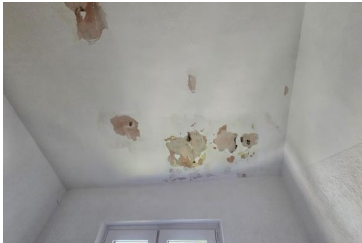
Feuchtschäden unterhalb des Treppenhausdaches
