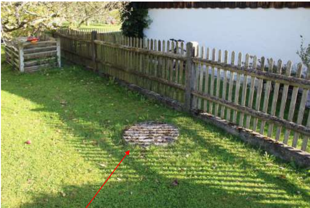
Abb. 9: Gruben-/Schachtabdeckung im nordöstlichen Grundstücksbereich
