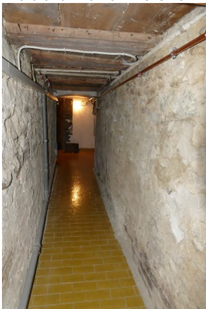
Bild 9 und Bild 10 – Kellerflur
