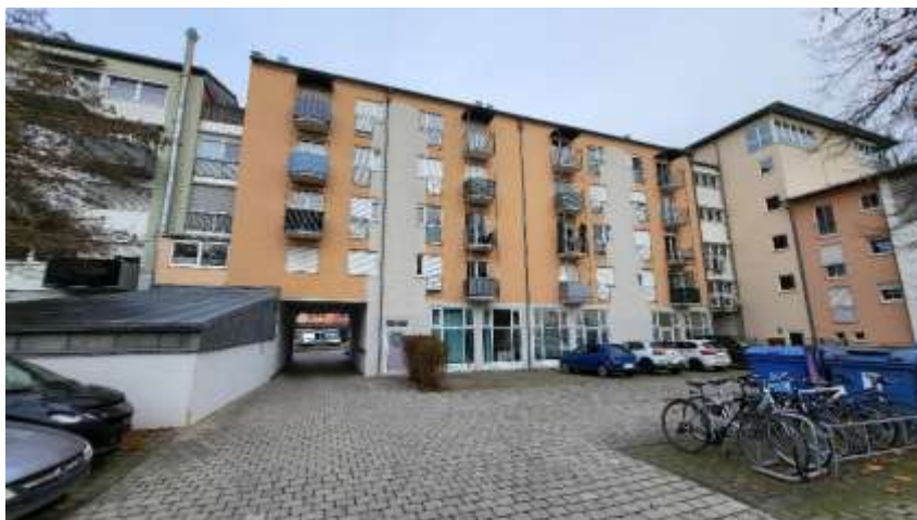
Bauteil A an der Münchener Straße, Hs.Nr.: 21a und 21 b Ansicht von Westen im Vordergrund Innenhof mit Parkplatz
