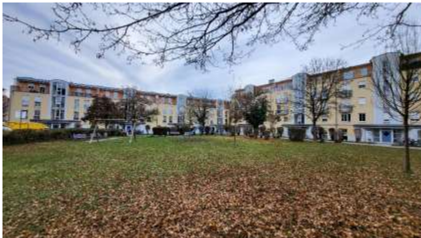
Bauteil B Bauteil C im Vordergrund Grünfläche mit Spielplatz über Tiefgarage
