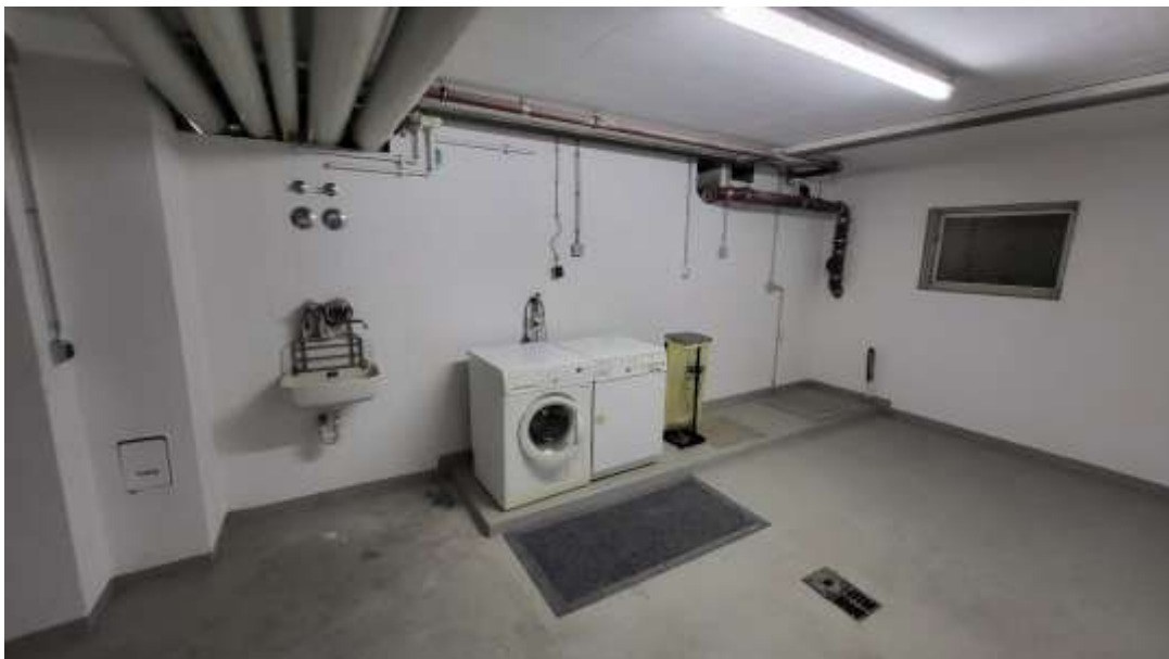
Wasch- und Trockenraum im Gebäude Münchener Straße 17d
