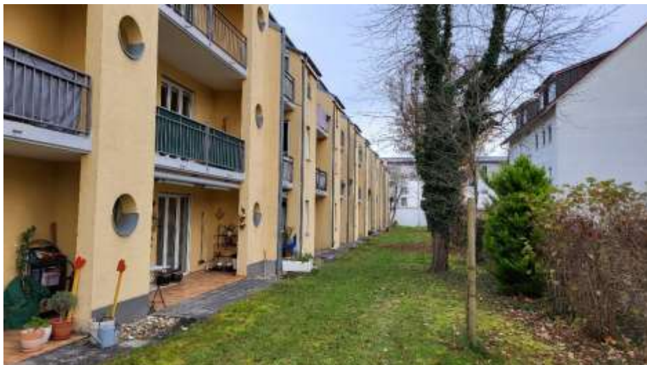
Bauteil B, Ansicht von Nordwesten
