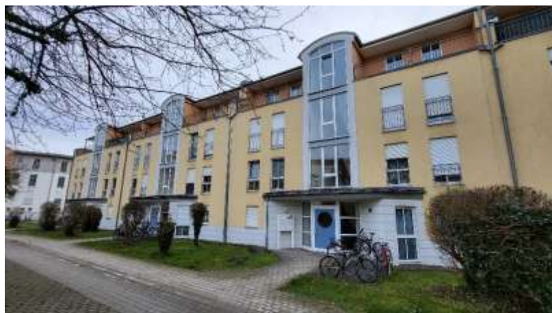
Ansicht von Nordwesten Bauteil B mit den Hs.Nrn.: 17e bis 17h
