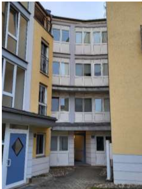
Ansicht von Osten, Eingang Hs.Nr.: 17d
