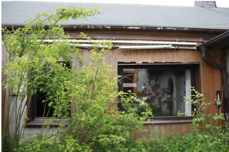
das Nebengebäude (im Lageplan N) von Westen
