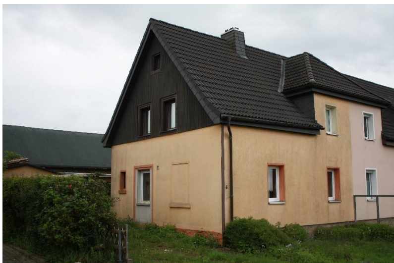
neues Dach, neuere Fenster und verschalter Giebel des Einfamilienwohnhauses
