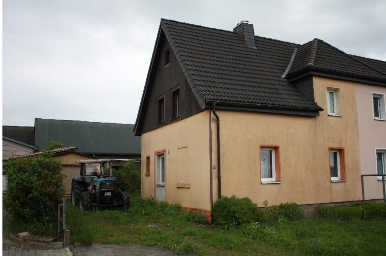
das Einfamilienwohnhaus von der Geroldsgrüner Straße aus gesehen (im Lageplan W)
