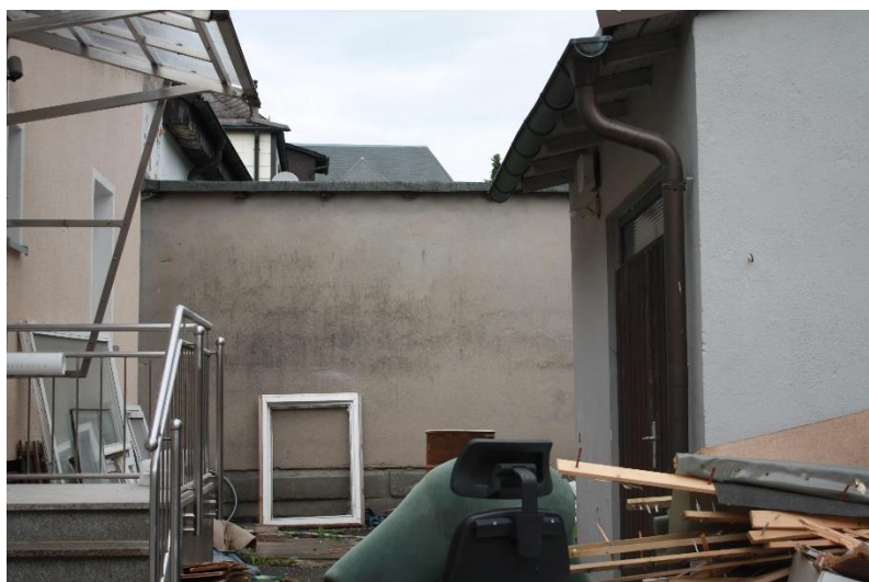
die Rückwand des Zwischengebäudes vom Grundstück Flur-Nr. 86/2 aus gesehen
