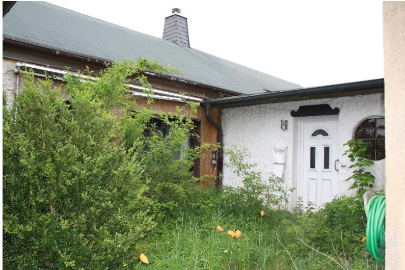
Zwischenbau zwischen Wohnhaus und Nebengebäude
