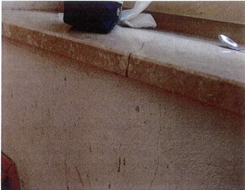
Abbildung (15) Rissausbildung im Bereich Diele unterhalb des Kellerfensters.
