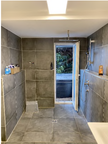
Bild 27 und Bild 28 – Bad
