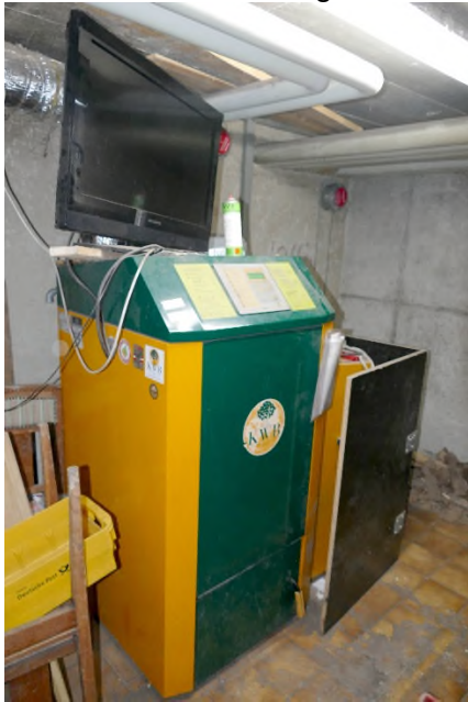
Bild 16 – Scheitholzheizkessel
