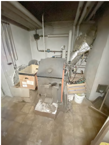
Bild 16 – Scheitholzheizkessel
