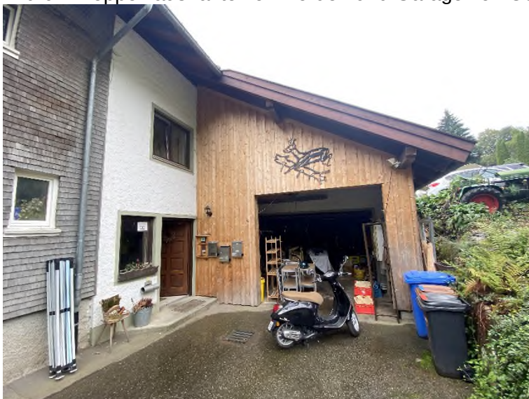
Bild 6 – Doppelhaushälfte von Norden und Garage von Osten
