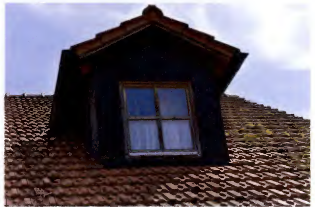
Dachgaube Nordseite mit verwitterten Holzrahmenfenstern
