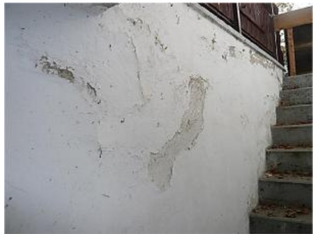
Kelleraußentreppe/Putzschäden
