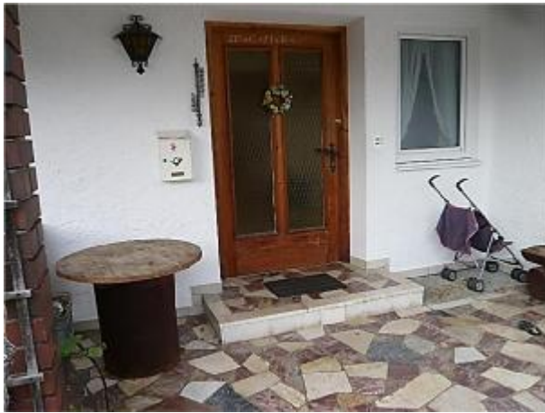
Hauseingang v. Osten
