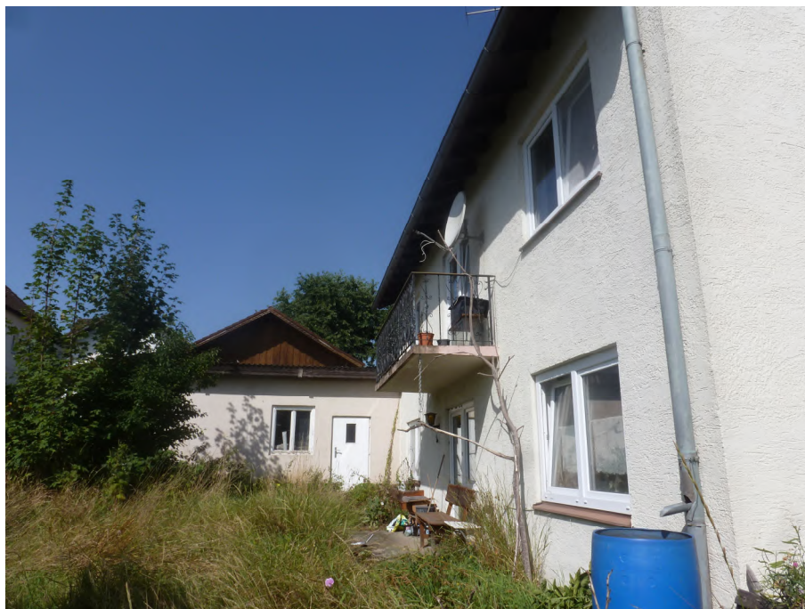
Blick von Osten auf das Einfamilienhaus und Nebengebäude
