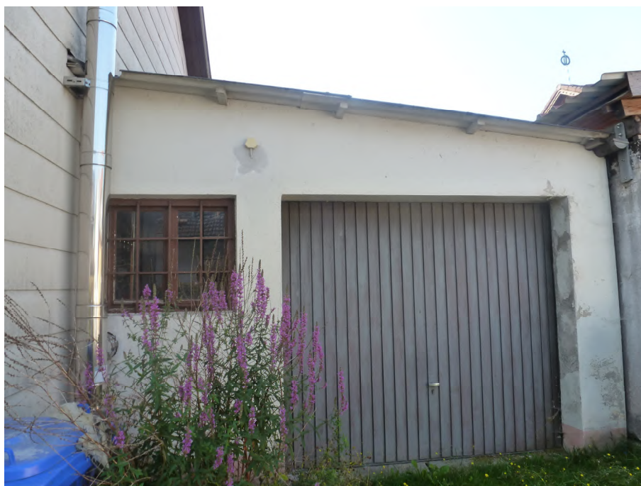
Blick von Norden auf das Nebengebäude
