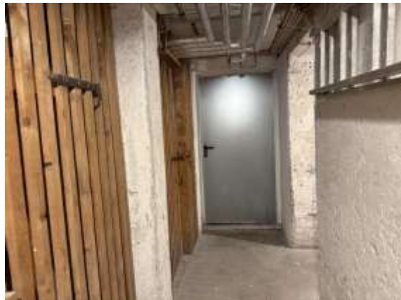
Kellergang mit Kellerabteil
