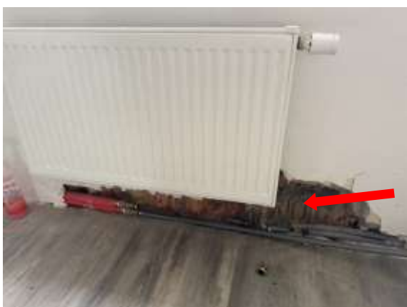
Detail Fertigstellungsbedarf (Heizung, Putz)
