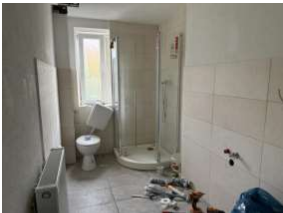
Bad, laufende Renovierung
