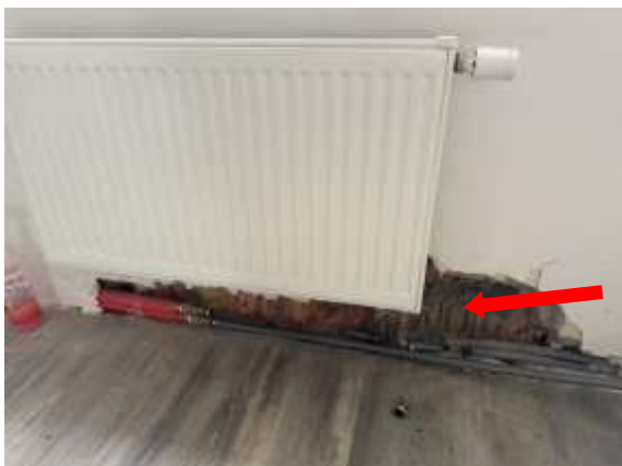
Detail Fertigstellungsbedarf (Heizung, Putz)
