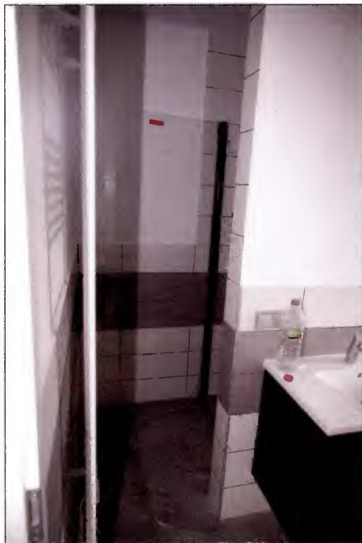
Foto 8 Erdgeschoss - Bad, Duschbereich
