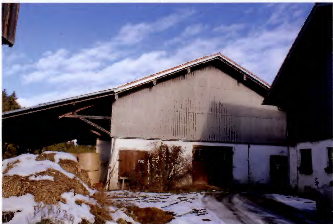
Zuwegung (nicht zum Flurstück gehörend); Südseite Rinderstall mit Vordach (Überbau)
