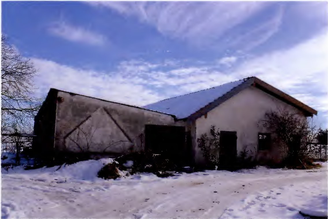
Remise und Maschinenhalle, Westseite
