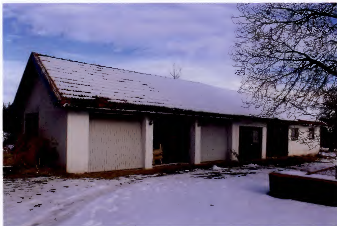
West- und Südseite
