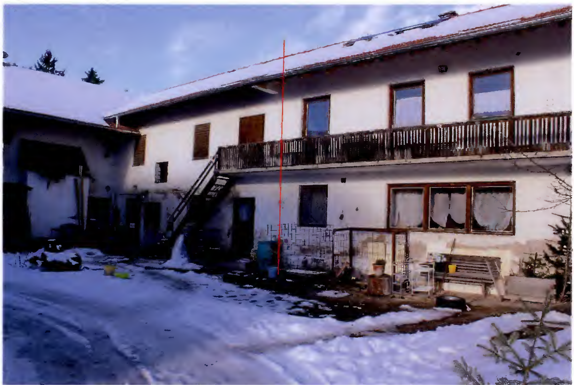
Südseite Wohnhaus, Detailansicht, Süd- und Ostseite Rinderstall
