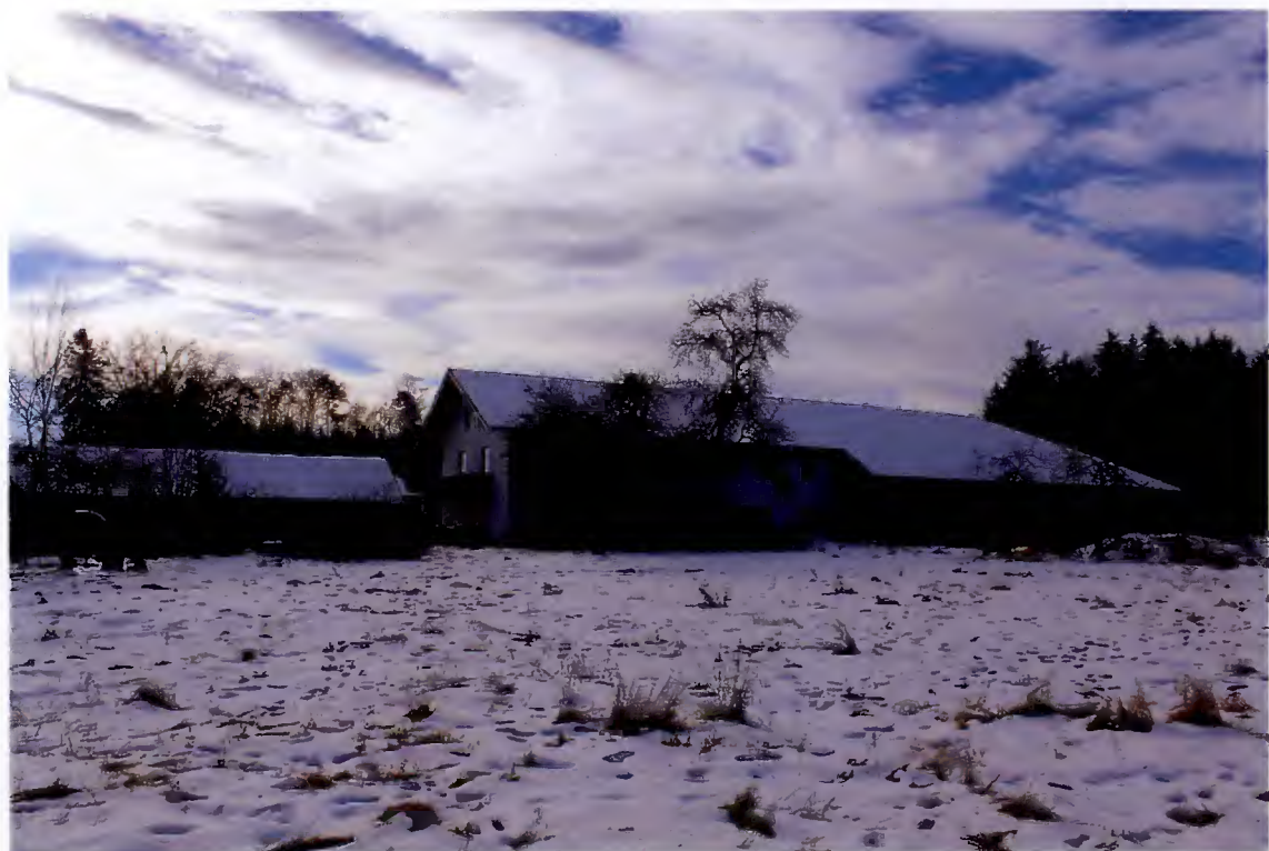
Nord- und Ostseite Wohnhaus, Nordseite Rinderstall; links davon Hühnerstall mit Garagen
