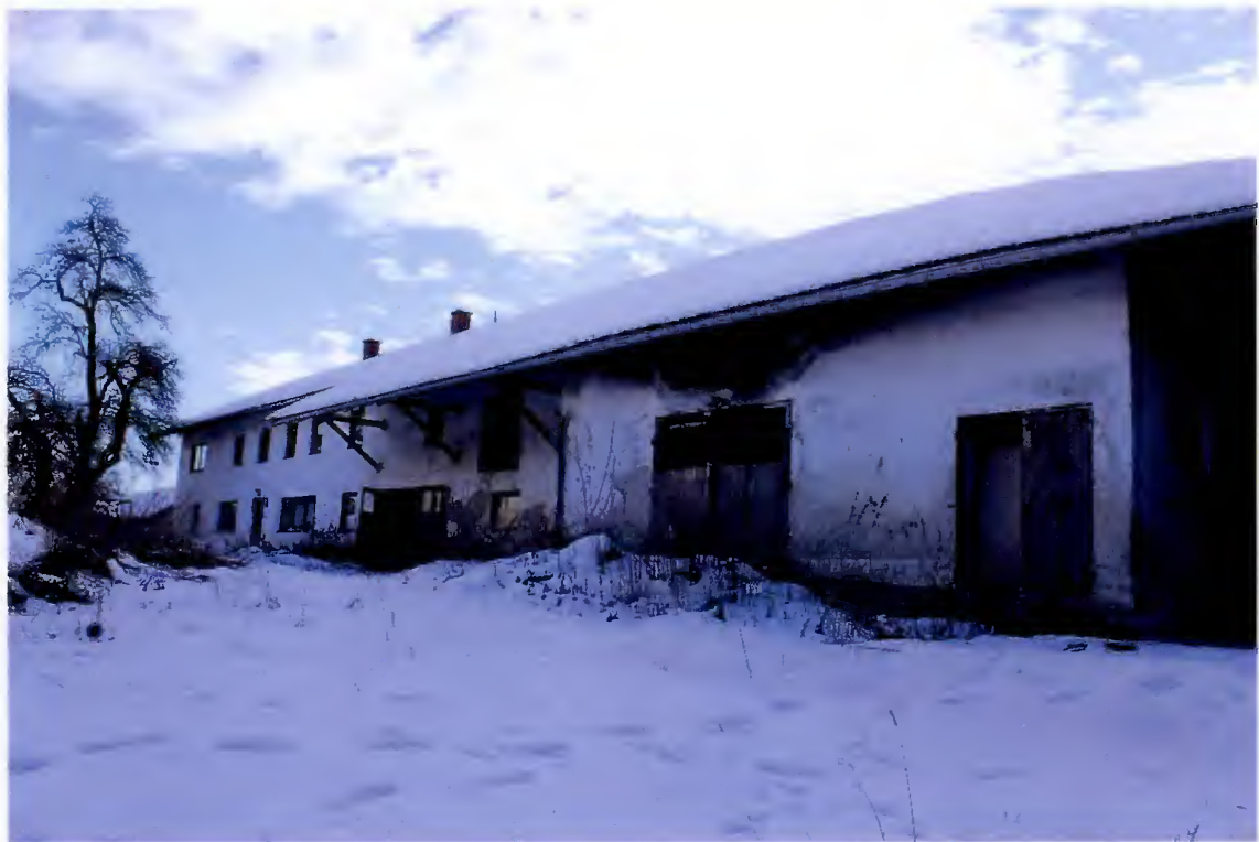
Nord- und Teile der Westseite des Rinderstalls; Nordseite des Wohnhauses
