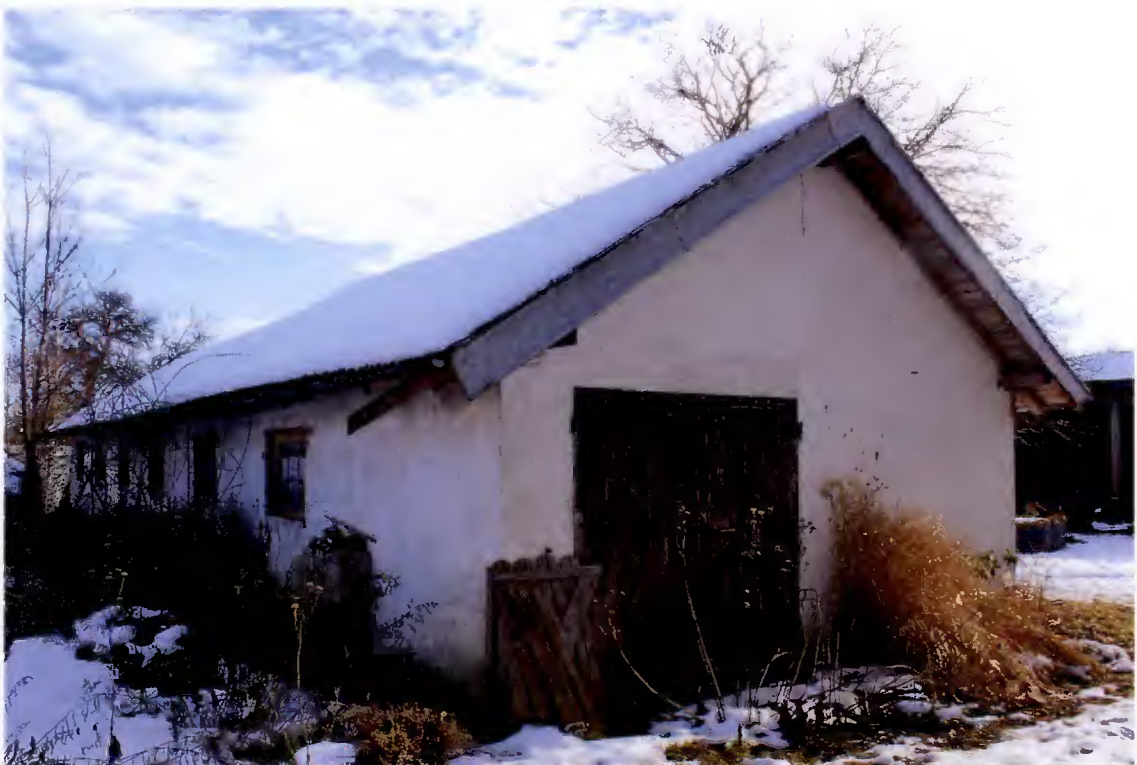
West- und Nordseite
