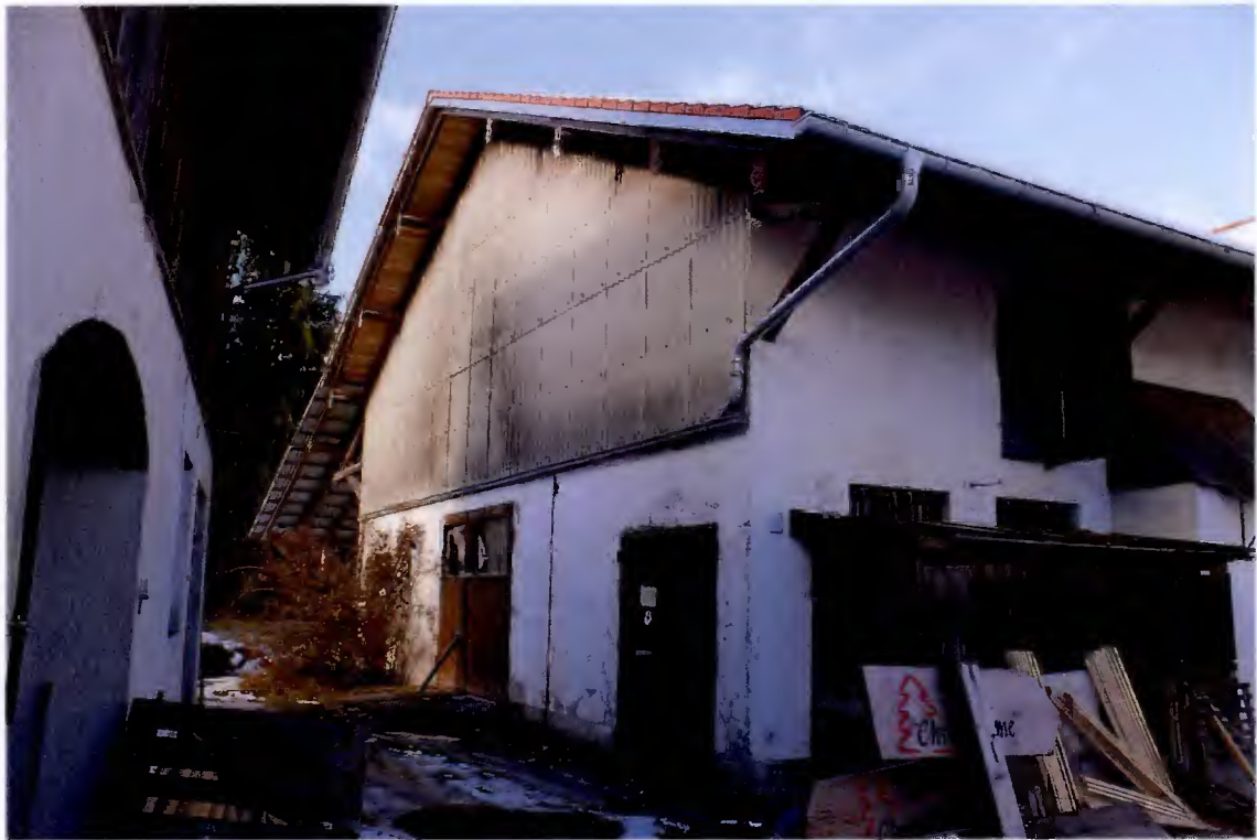
Rinderstall, Süd- und Ostseite; links: Nebengebäude mit Boxenanbau
