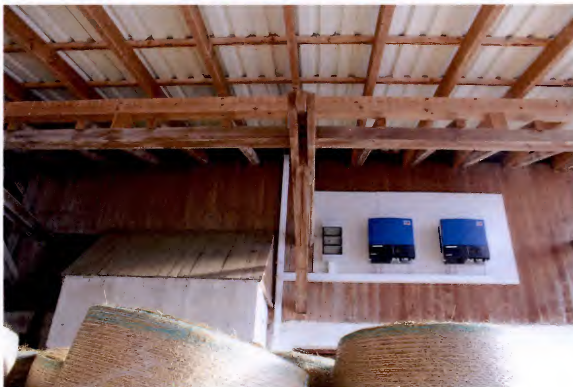
Dachuntersicht Vordach; Installation zur Photovoltaikanlage (kein Zubehör)
