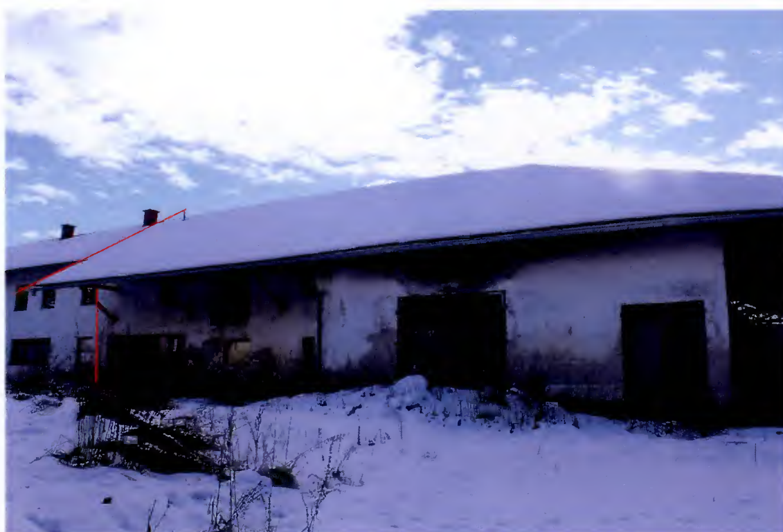
Nordseite Rinderstall; links daran anschließend: Wohngebäude
