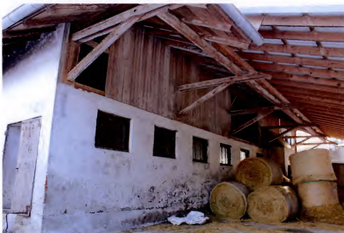
Westseite Rinderstall mit Vordach (Überbau)
