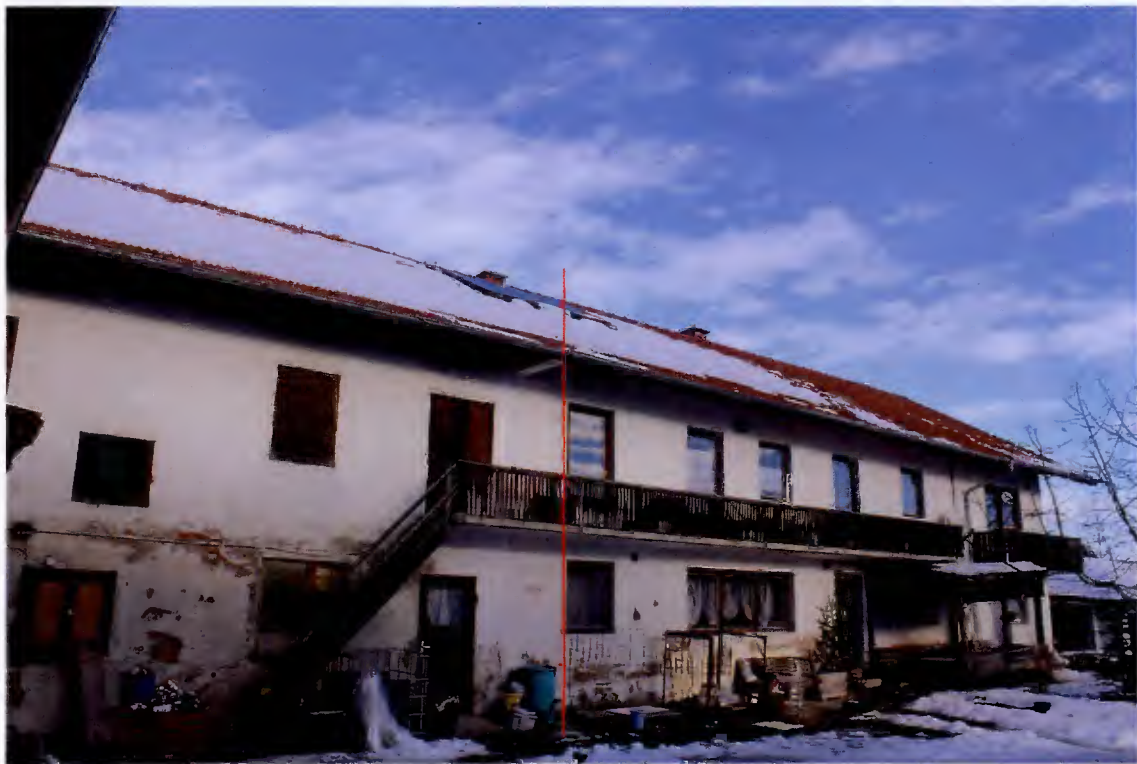
Südseite Wohngebäude und Rinderstall/Milchkammer
