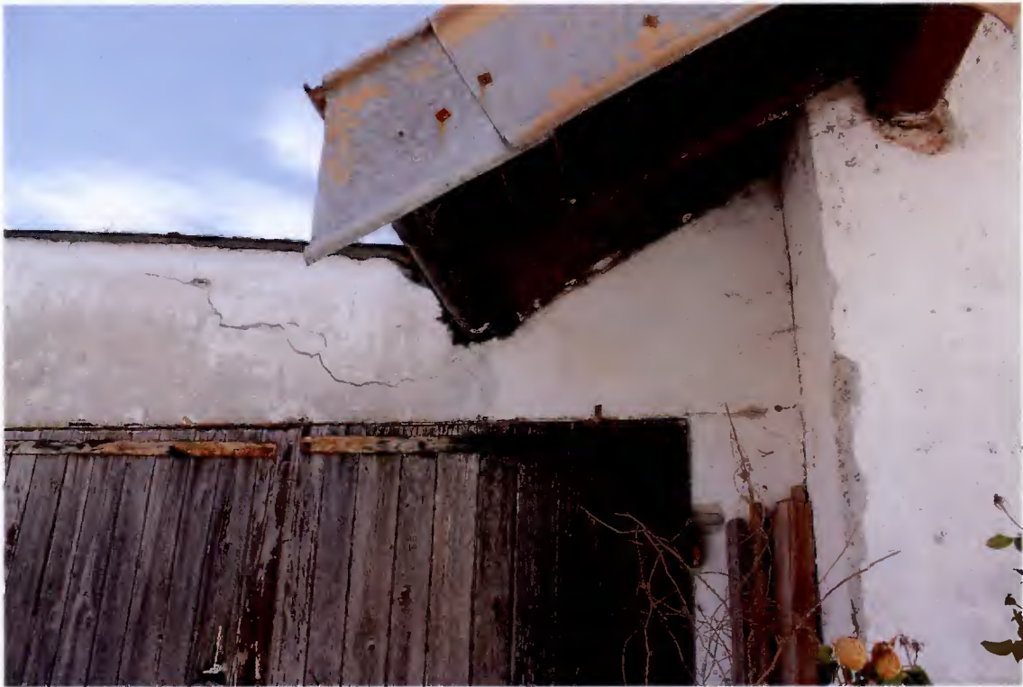
Detailaufnahme Remise mit Gebäudeanschluss an die Maschinenhalle
