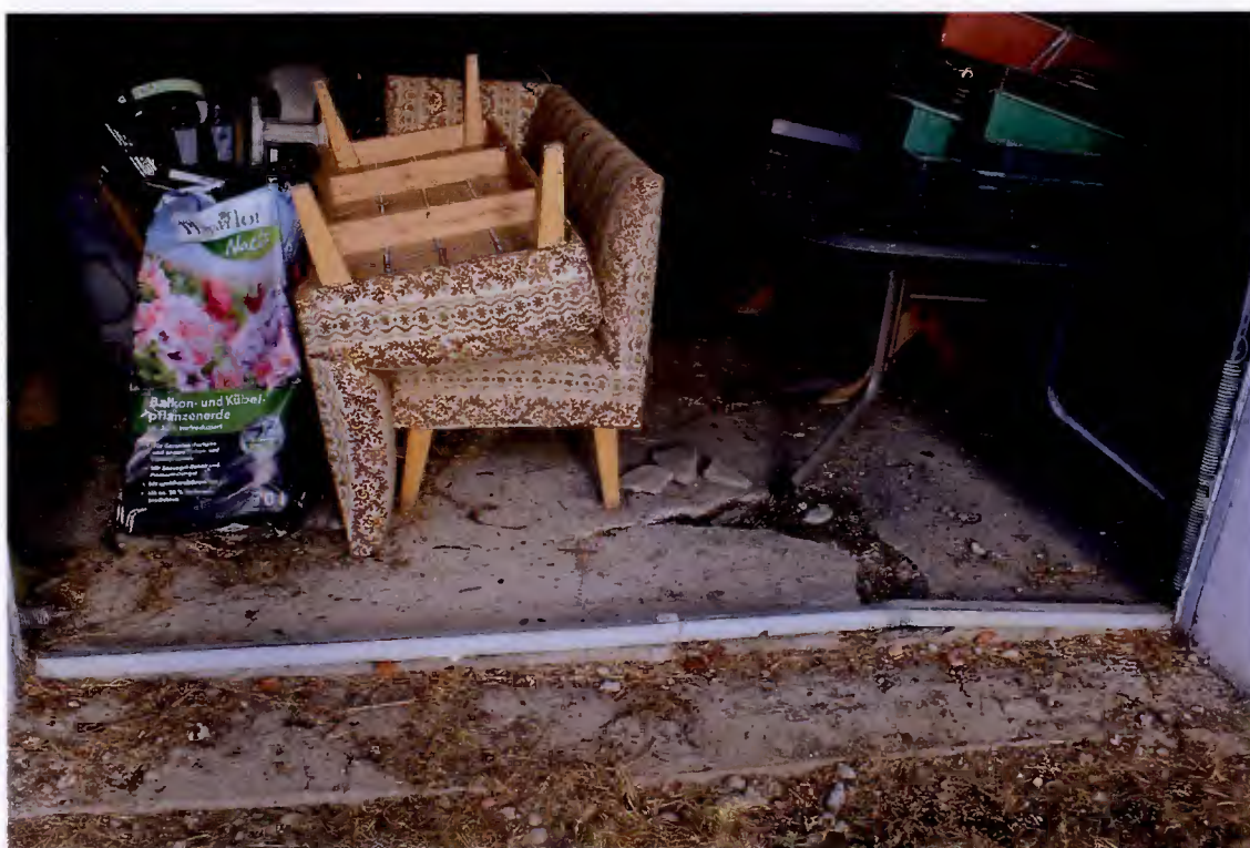
Detailaufnahme, mittlere Garage
