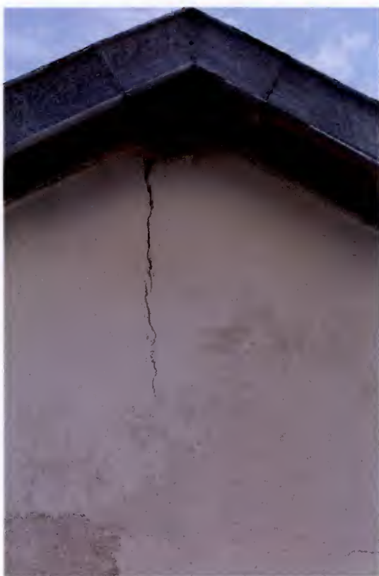
Detailaufnahme, Westseite Giebel
