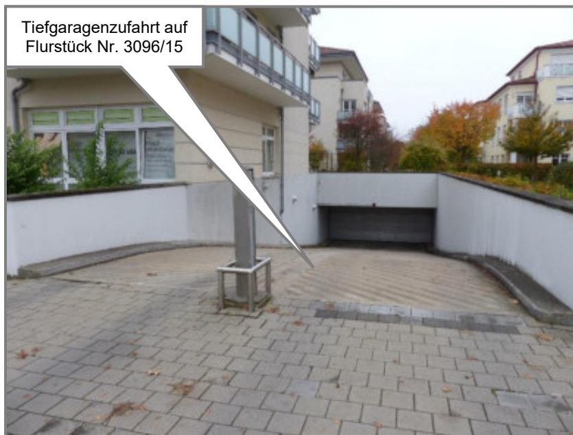
Tiefgaragenzufahrt von der Straße „Esplanade“ nordöstlich des Bewertungsgrundstückes über das Nachbargrundstück
