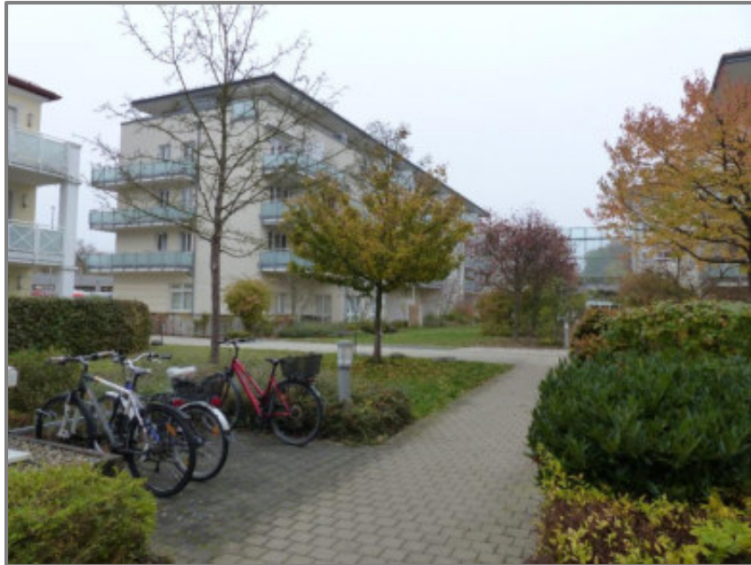
mittiger Grundstücksbereich zwischen den Mehrfamilienhäusern Hausnummer 19 und 19a - Blick nach Norden zum Nachbargrundstück, Flurstück Nr. 3096/15
