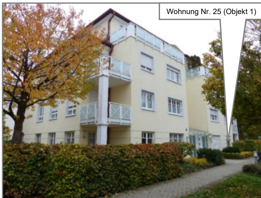
Hausnummer 19a - Ansicht von Norden
