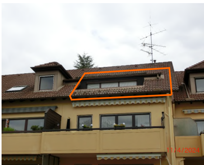
Teil der Gebäudefassade NW, Position Bewertungswohnung zu A) lt. ATP B7
