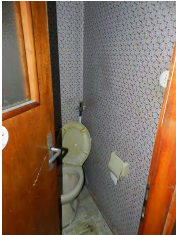
WC EG (vom Treppenhaus begehbar)
