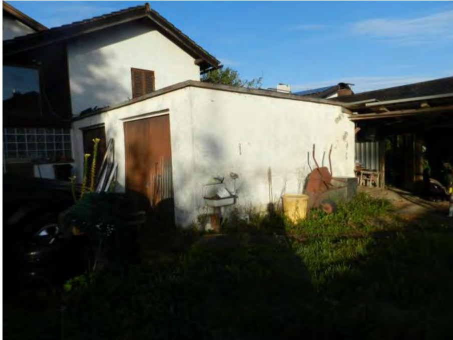
Ansicht Garage von Osten
