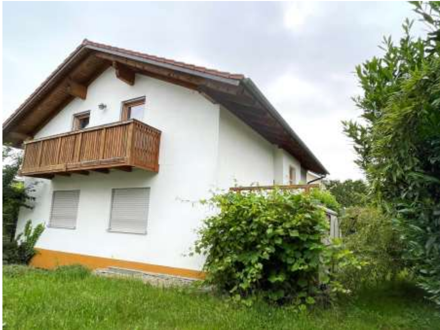
beispielhafte Ansicht der Nordostseite des Einfamilienhauses
