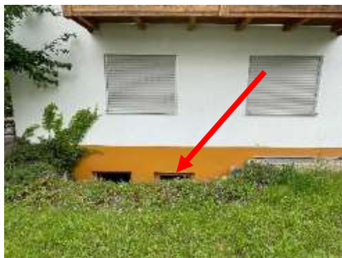
beispielhafte Ansicht der Fenster im Hobbyraum des Kellergeschosses
