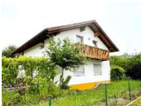
beispielhafte Ansicht des Holzbalkons mit Holzgeländer und Holzhandlauf zur Ostseite
