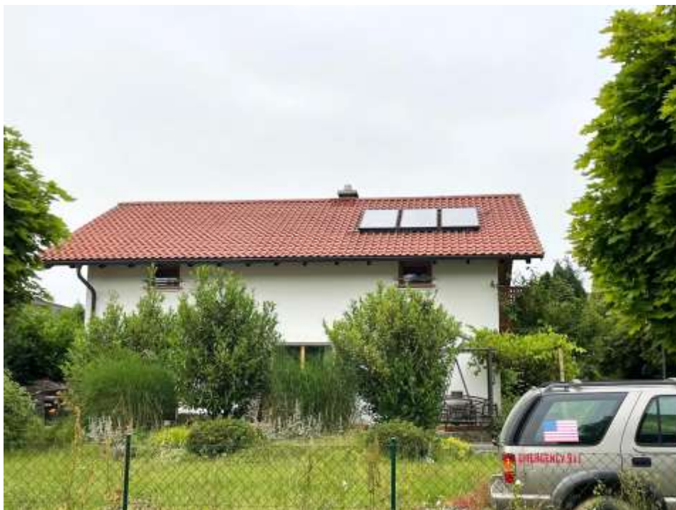
beispielhafte Ansicht der Südseite des Einfamilienhauses
