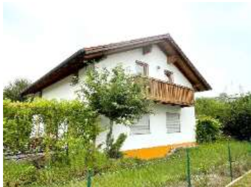
beispielhafte Ansicht der Südostseite der Fassade
