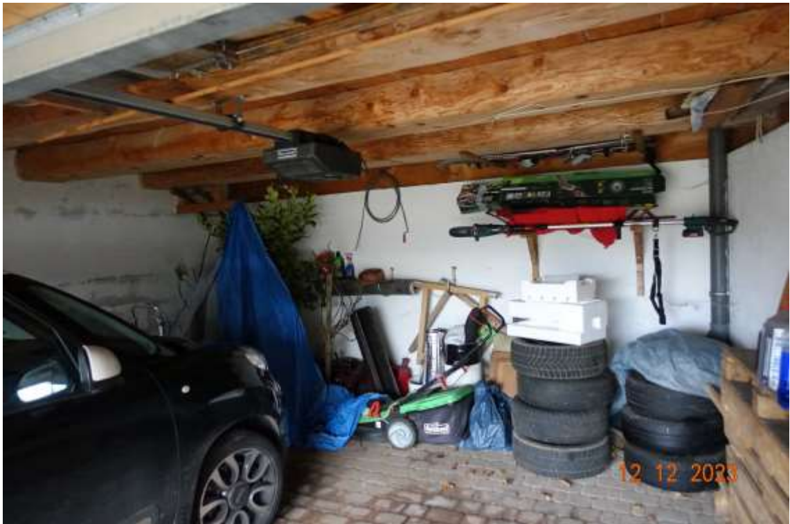
Abbildung 5: Holzbalkendecke in der Doppelgarage zum ausgebauten Dachgeschoss
