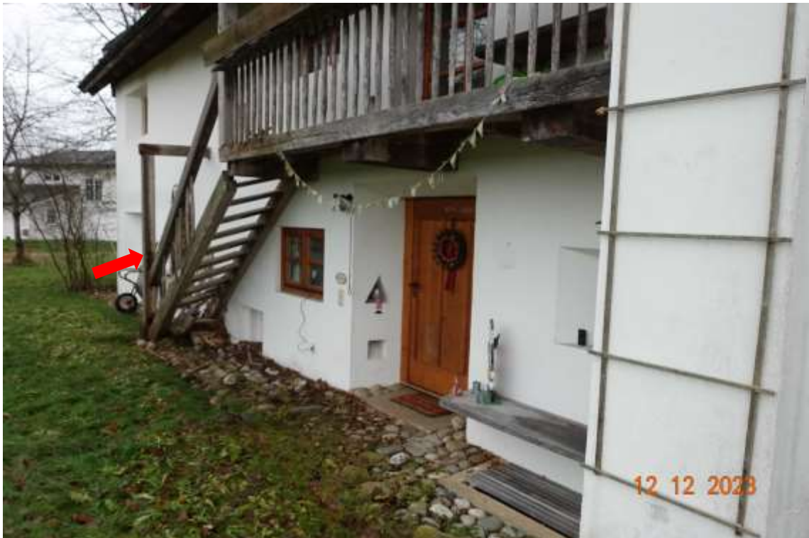
Abbildung 11: Nordostseite und Eingangsbereich mit schadhafter Holztreppe zum OG
