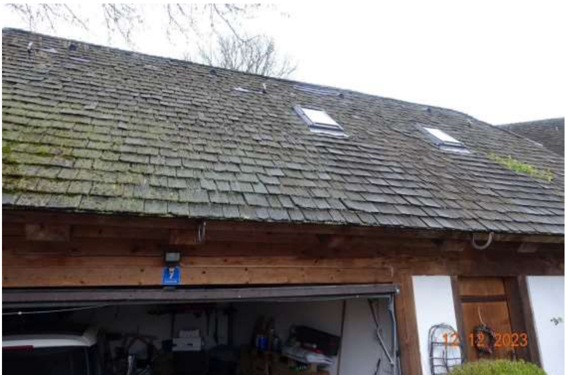
Abbildung 4: Dacheindeckung aus Holzschindeln bei Wohnhaus und Nebengebäude
