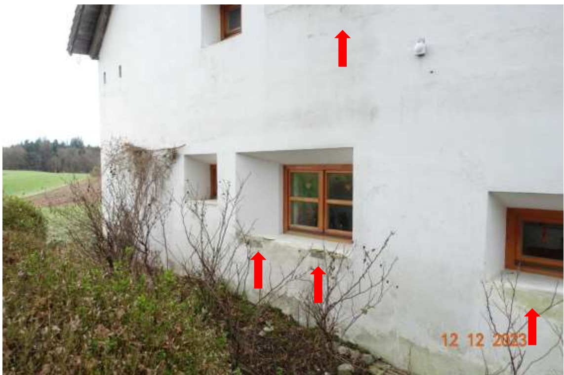
Abbildung 10: Nordwestliche Giebelseite mit Putz- bzw. Farbabblösungen
