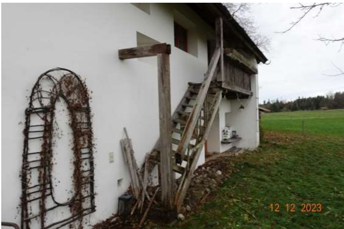
Abbildung 12: Äußerer Zugang zum OG mit schadhafter Holztreppe
