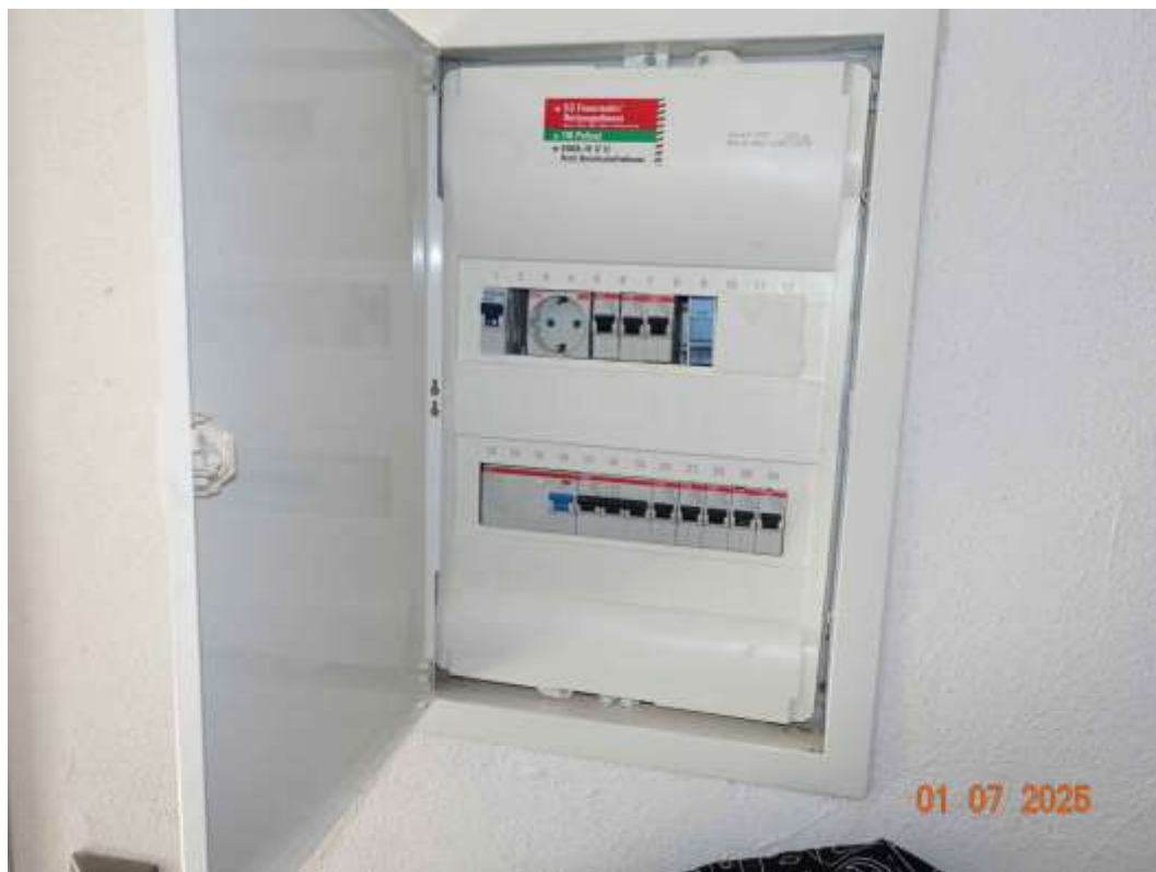
Abbildung 23: Zeitgemäße Absicherung durch elektronische Kippsicherungen
