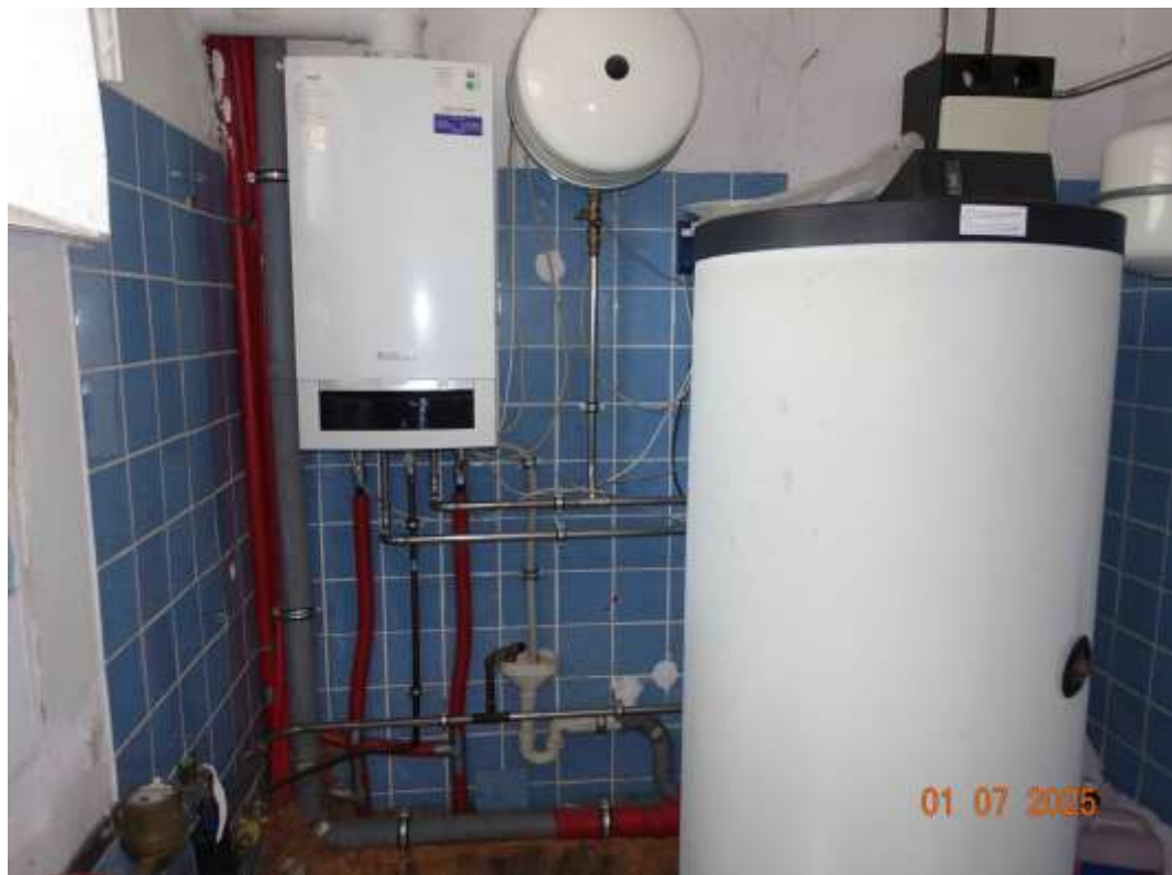
Abbildung 18: Zentrale Heizungsanlage im Erdgeschoss
