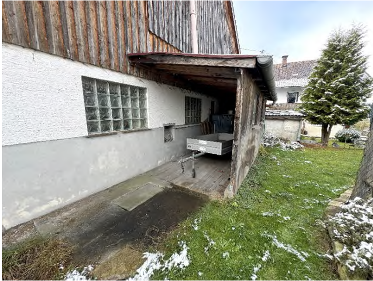
Bild 36 – Überdachung auf Güllegrube auf Nachbargrundstück FINr. 1265
