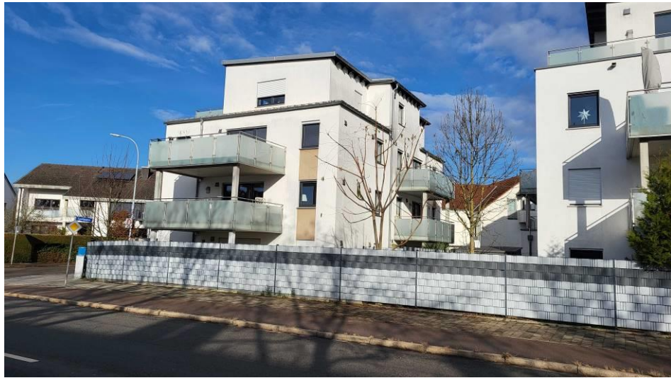
Ansicht von Südosten, im Vordergrund die Peisserstraße
