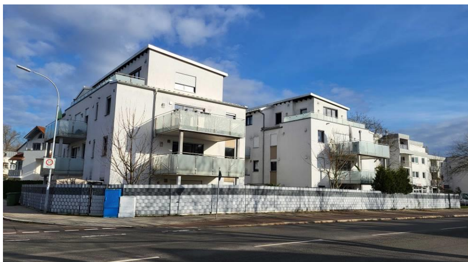
Ansicht von Südwest, im Vordergrund die Peisserstraße
