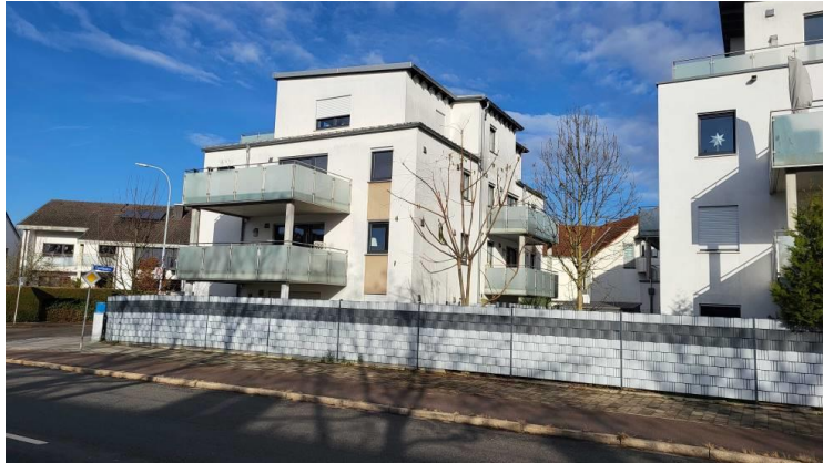
Ansicht von Südosten, im Vordergrund die Peisserstraße
