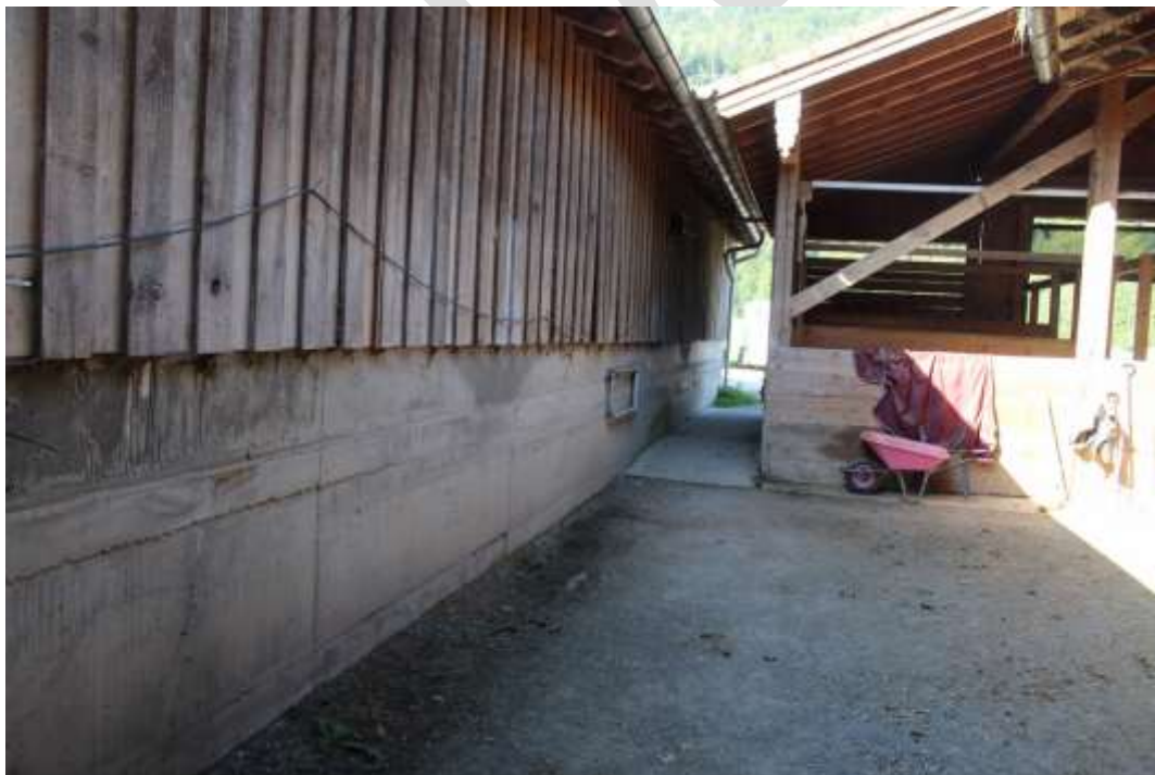
Abb. 4: Stallgasse/Aufenthaltsbereich - Südgrenze mit naher Nachbarbebauung
