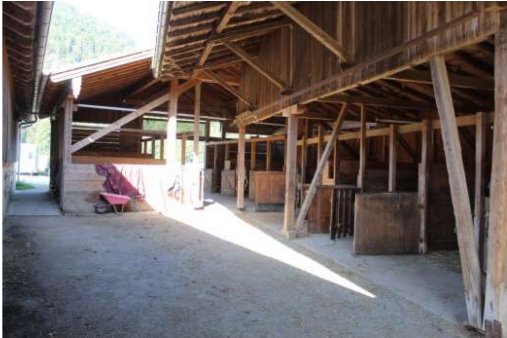
Abb. 1: Stallgebäude von Innen – Blick nach Westen, Hintergrund im Westen Maschinenhalle, die ebenfalls mit Pferdeboxen ausgebaut ist.
