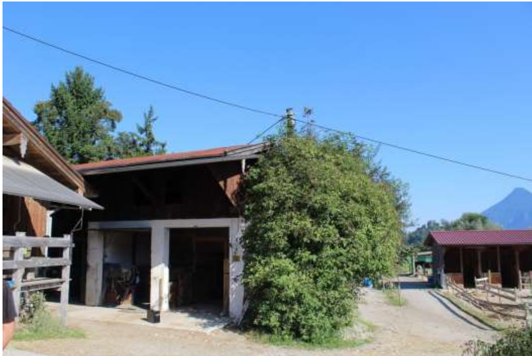
Abb. 3: Teilweiser Überbau ostseitig – als Boxen umfunktionierte Doppelgarage
