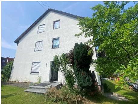
Bewertungsobjekt (Ansicht von Osten)
