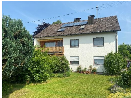
Bewertungsobjekt (Ansicht von Süden)
