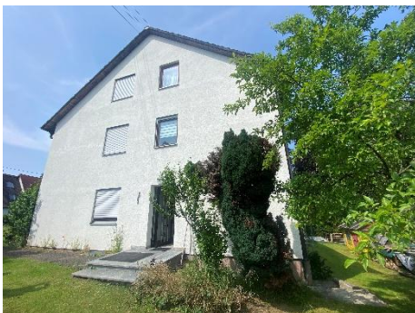
Bewertungsobjekt (Ansicht von Osten)
