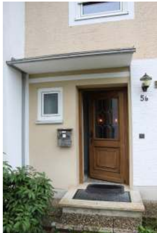
Detailansicht Hauseingang mit Vordach
