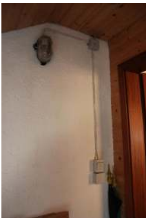
Leitungen über Putz Dachgeschoss
