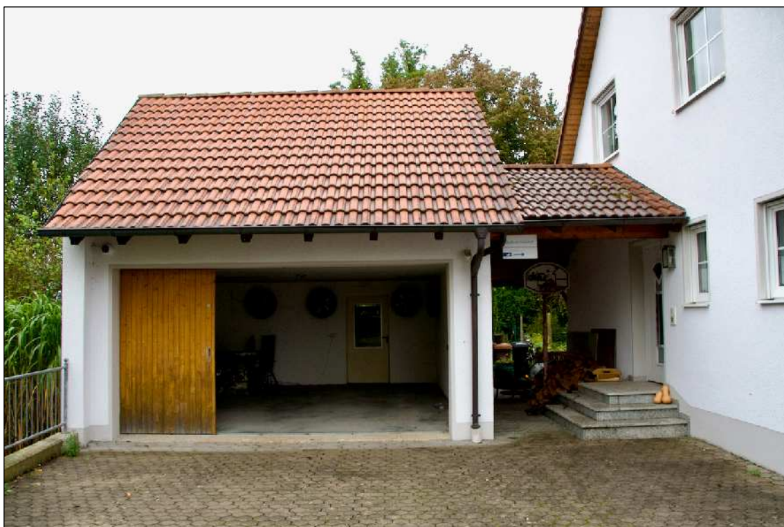
Foto 2 Doppelgarage mit Eingangsüberdachung
