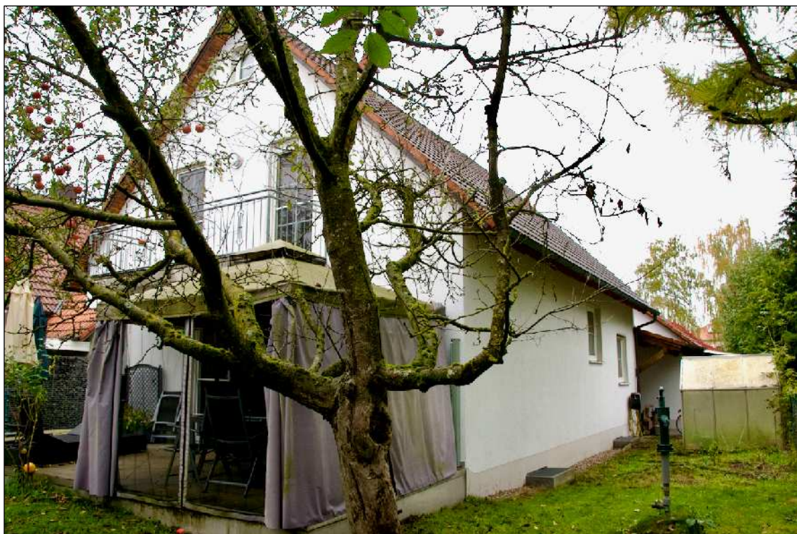
Foto 4 Ansicht von Osten
