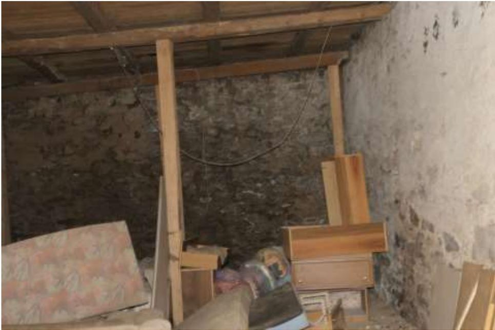
Bild 5: zwei Holzstützen tragen die teilweise verfaulte Holzkonstruktion
