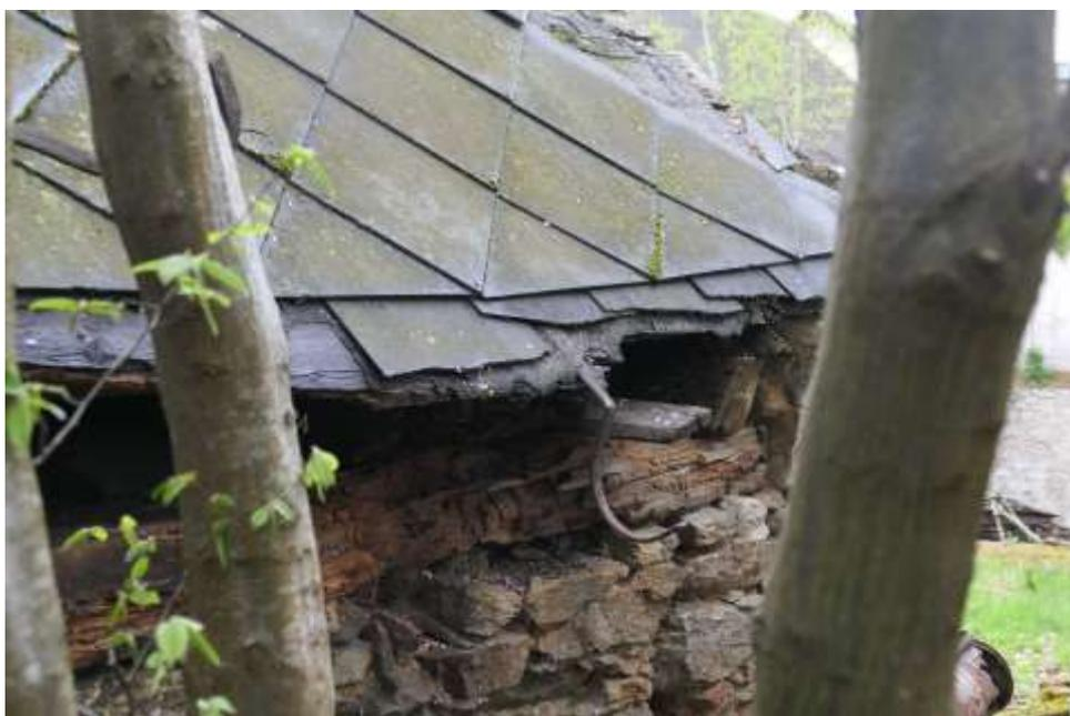
Bild 4: Balkenauflage des Daches zum Mauerwerk komplett durchgefaut
