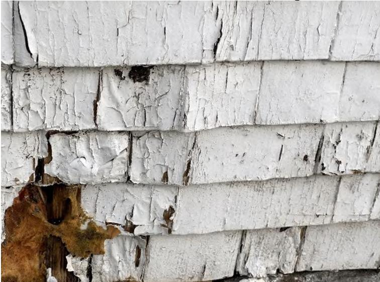
Bild 29 – Schäden an Holzschindelbekleidung auf Westseite
