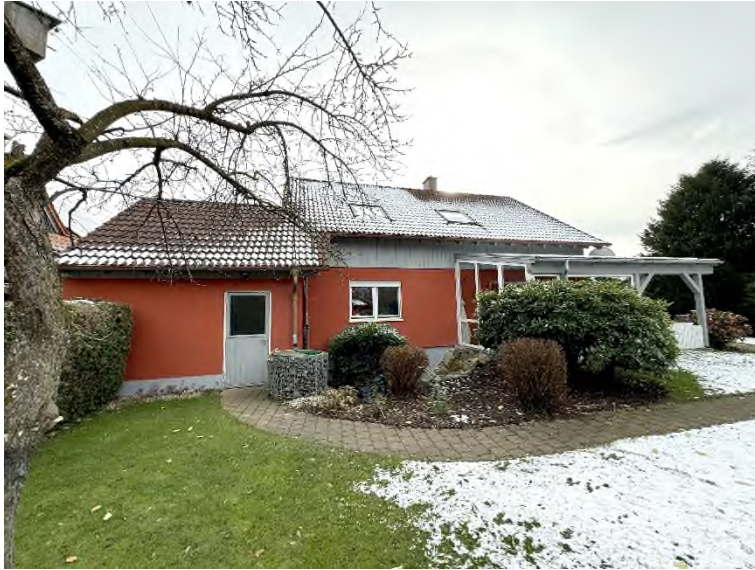
Bild 5 – Garage und Wohnhaus von Nordwesten
