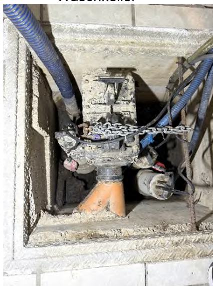
Bild 9 – Blick in Pumpschacht im Waschkeller
