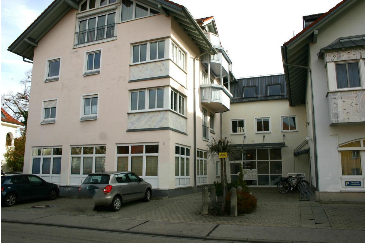
Gebäudeteilansicht – Eingangsbereich – Westseite
