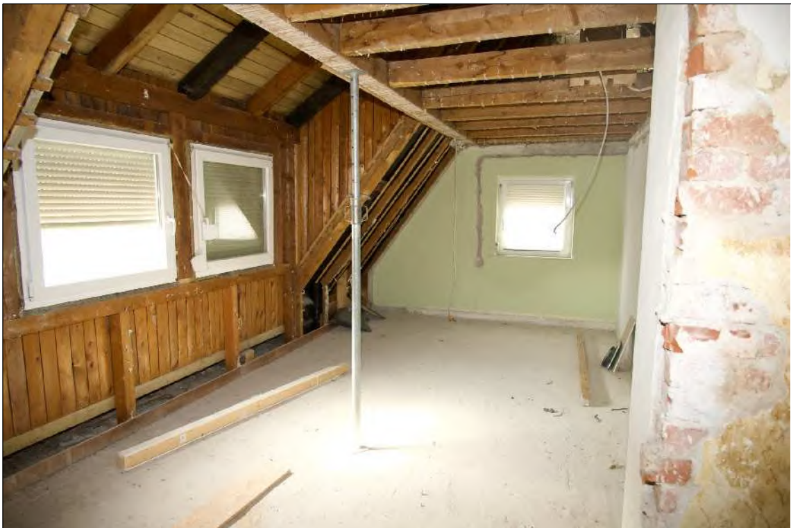
Foto 10 Dachgeschoss - nicht ausgebauter Dachraum
