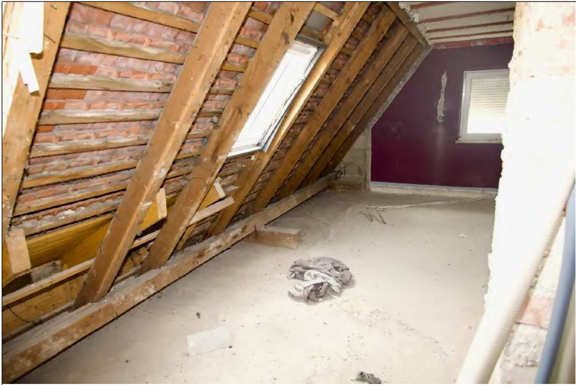
Foto 9 Dachgeschoss - nicht ausgebauter Dachraum
