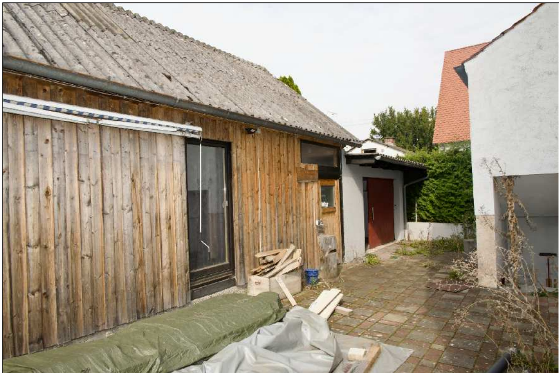
Foto 16 Nebengebäude und Garage
