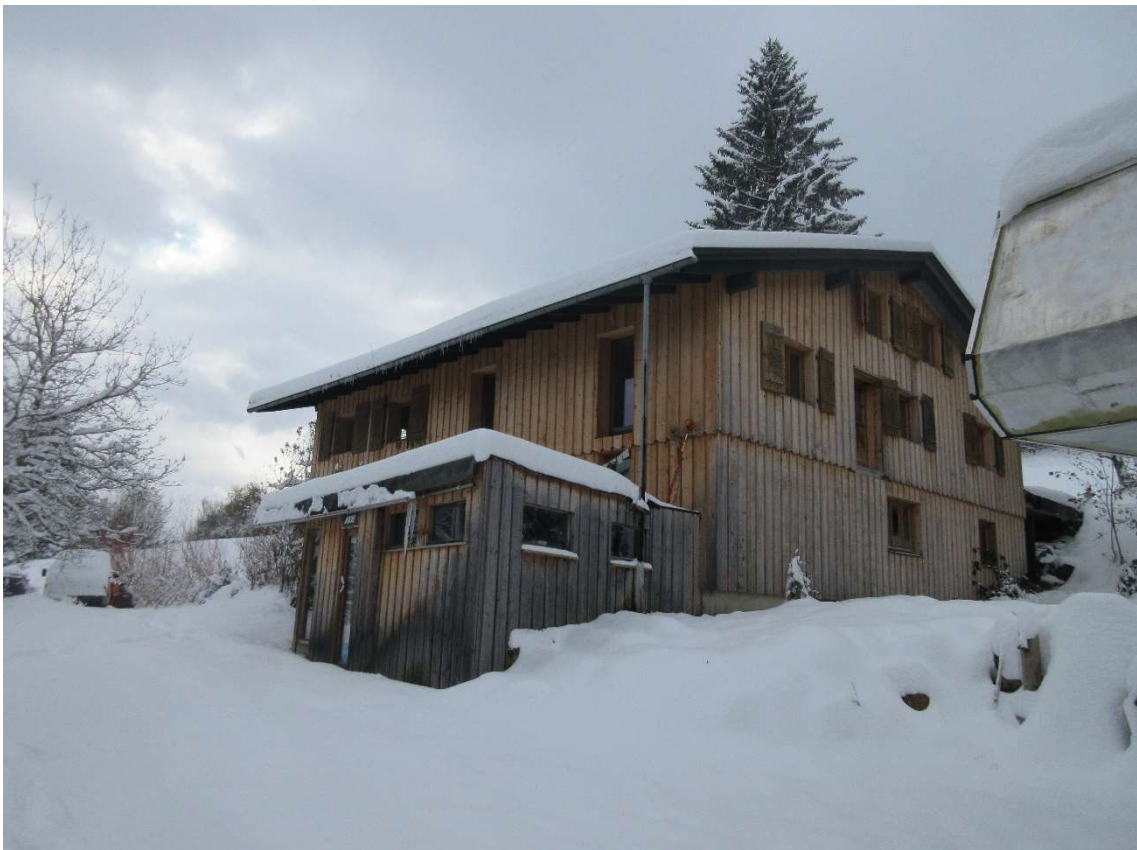
Foto 4: Nord- und Ostseite des Wohnhauses mit Anbau Ost von Nordosten
