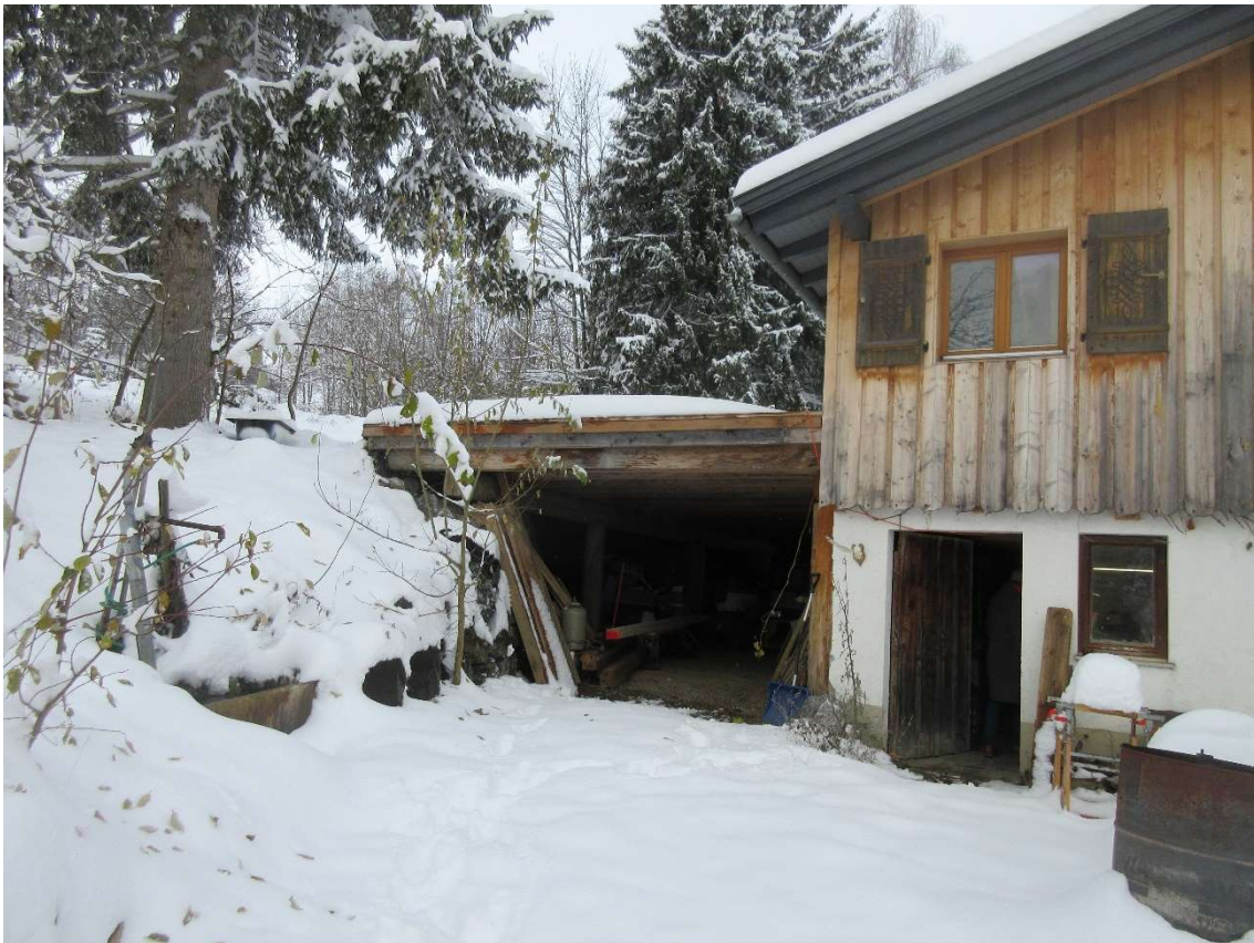
Foto 5: Südseite des Wohnhauses mit Anbau West
