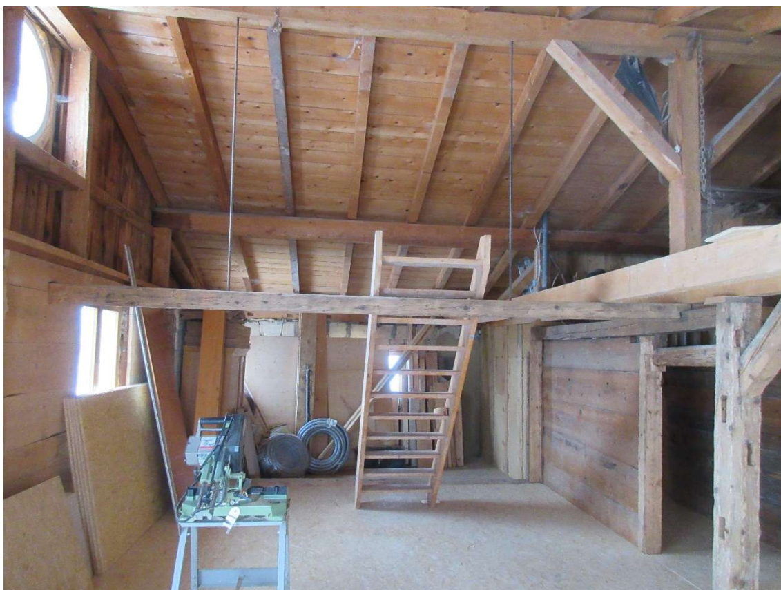
Foto 12: Südlicher Bereich des Obergeschosses mit sichtbarem Dachstuhlbereich
