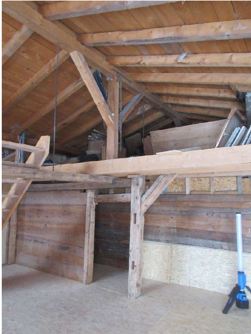
Foto 13: Blick vom südlichen Bereich des Obergeschosses des Wohngebäudes zum nördlichen Bereich
