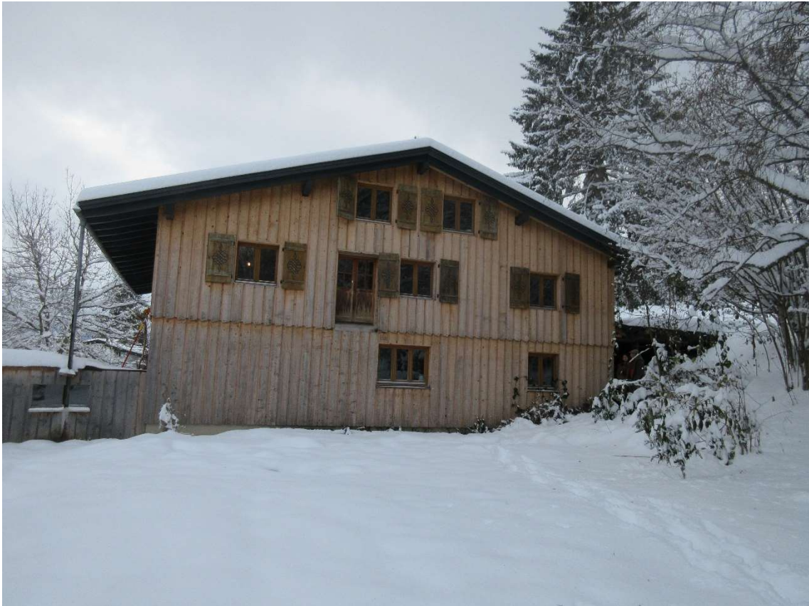
Foto 3: Nordseite des Wohnhauses
