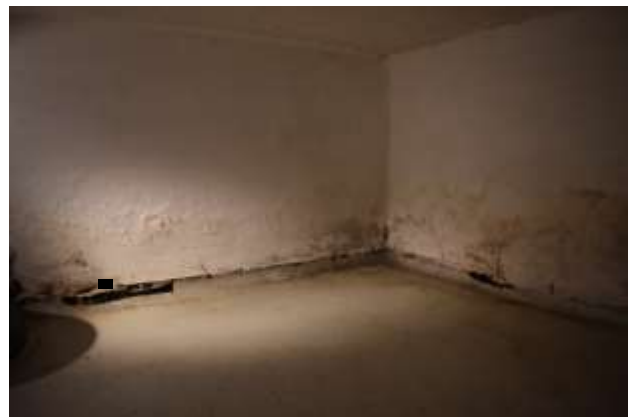
Kellergeschoss mit fast durchgängiger Wandfeuchtigkeit
